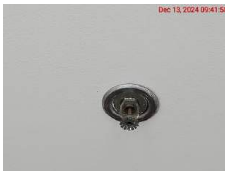
หัวฉีดน้ำ (Sprinkler)
