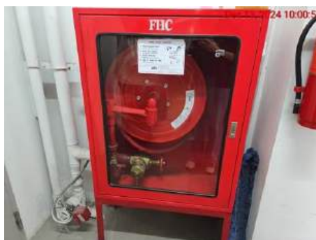
ตู้เก็บสายฉีดน้ำดับเพลิงพร้อมอุปกรณ์ (FHC)
