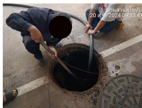
การสูบลากตะกอนจากระบบบำบัดน้ำเสีย อาคาร 2
