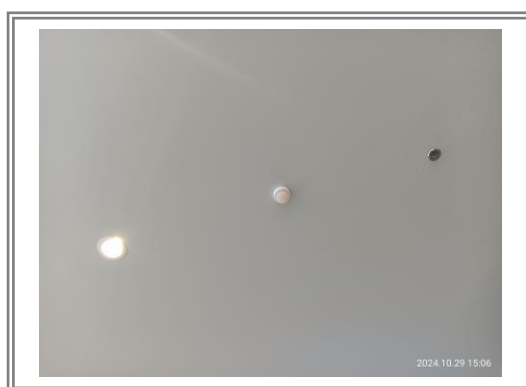
รูปที่ 2.8-2 อุปกรณ์ตรวจจับควัน
