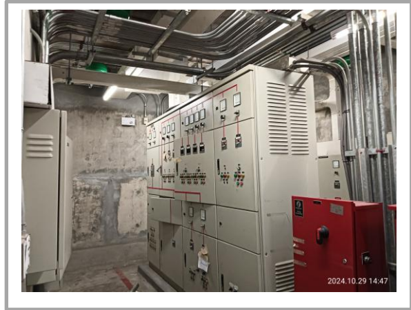
รูปที่ 3.1-25 ตู้ควบคุมระบบบำบัดน้ำเสีย
