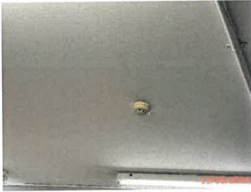
รูปที่ 34 เครื่องตรวจจับควัน
