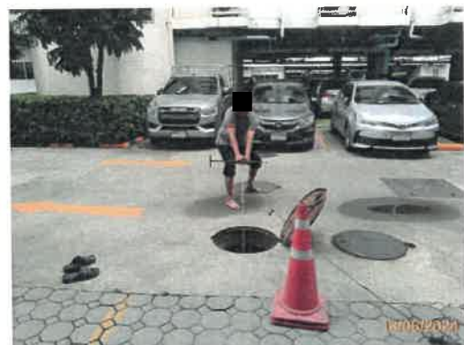
รูปที่ 20 พนักงานตัดกากไขมันจากบ่อดักไขมัน เป็นประจำสัปดาห์ละ 1 ครั้ง
