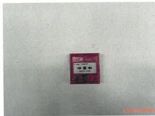
รูปที่ 39 เครื่องแจ้งเหตุโดยใช่มือดึง (Manual Station)
