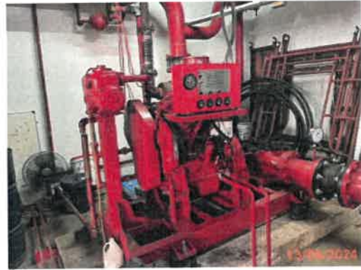
รูปที่ 35 เครื่องสูบน้ำดับเพลิง (Fire pump)
