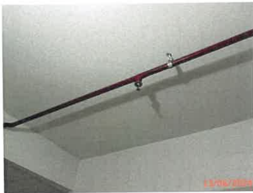
รูปที่ 38 หัวฉีดน้ำอัตโนมัติ
