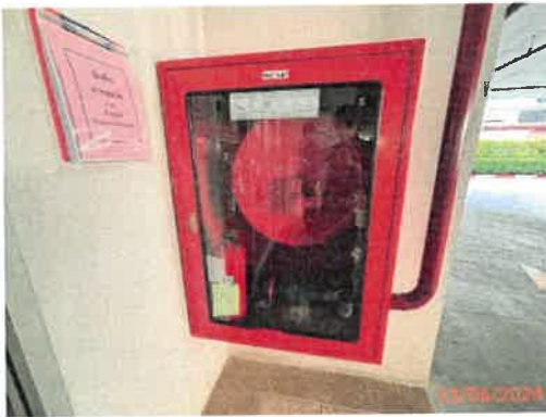
รูปที่ 36 ตู้เก็บสายฉีดน้ำดับเพลิง
