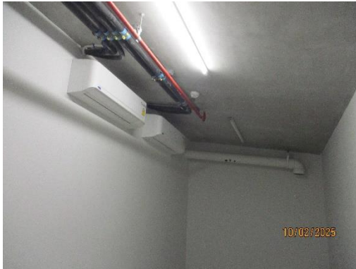
รูปที่ 26 เครื่องปรับอากาศภายในห้องพักขยะเปียก
