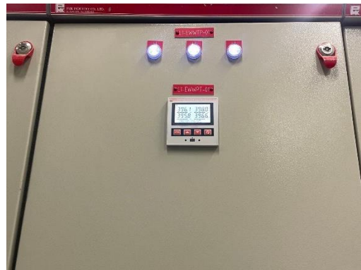
รูปที่ 29 มิเตอร์ไฟฟ้าแยกเฉพาะส่วนของระบบบำบัดน้ำเสีย
