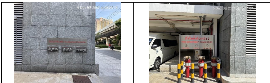
รูปภาพที่ 2-30 ห้รับน้ำดับเพลิงภายในโครงการ อาคาร 1 และ อาคาร 2
