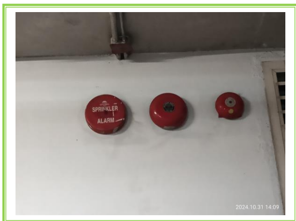
รูปที่ 3-41 กริ่งสัญญาณเตือนภัย
