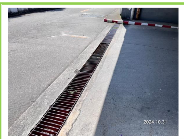
รูปที่ 3-32 รางระบายน้ำบริเวณทางเข้าอาคารจอดรถ
