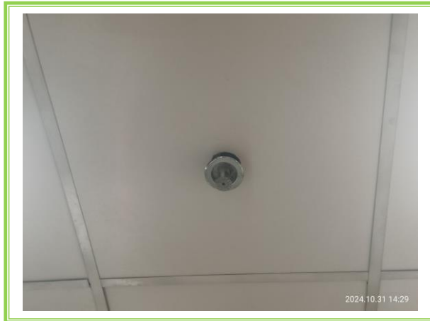
รูปที่ 3-45 ระบบหัวกระจายน้ำดับเพลิงอัตโนมัติ
