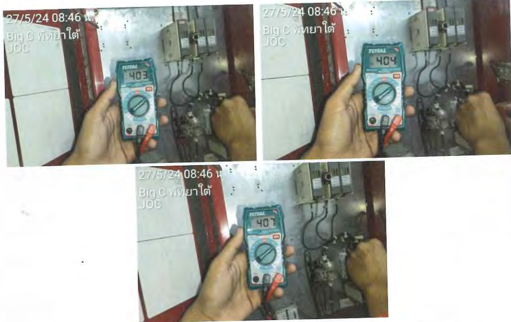
รูปที่ 2.9 ทดสอบแรงดันไฟฟ้าจากตู้ควบคุมเครื่องสูบน้ำรักษาแรงดัน Jockey Pump
