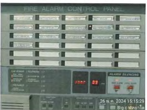
รูปที่ 2.87 ตู้ควบคุม และตู้กราฟฟิกแสดงผลแจ้งเหตุเพลิงไหม้ zone 09(DZ-2PR)
