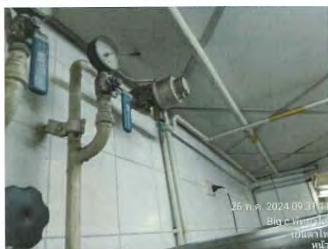
รูปที่ 2.102 ทดสอบ Gas controller และ Shut off valve พื้นที่ร้านเบ็นตาไฟ หน้า
