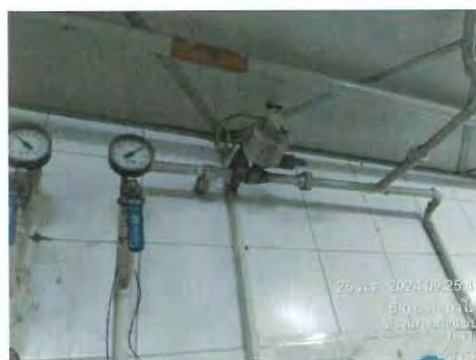
รูปที่ 2.103 ทดสอบ Gas controller และ Shut off valve พื้นที่ร้านข้าวแกงเล้งแซบ กลาง
