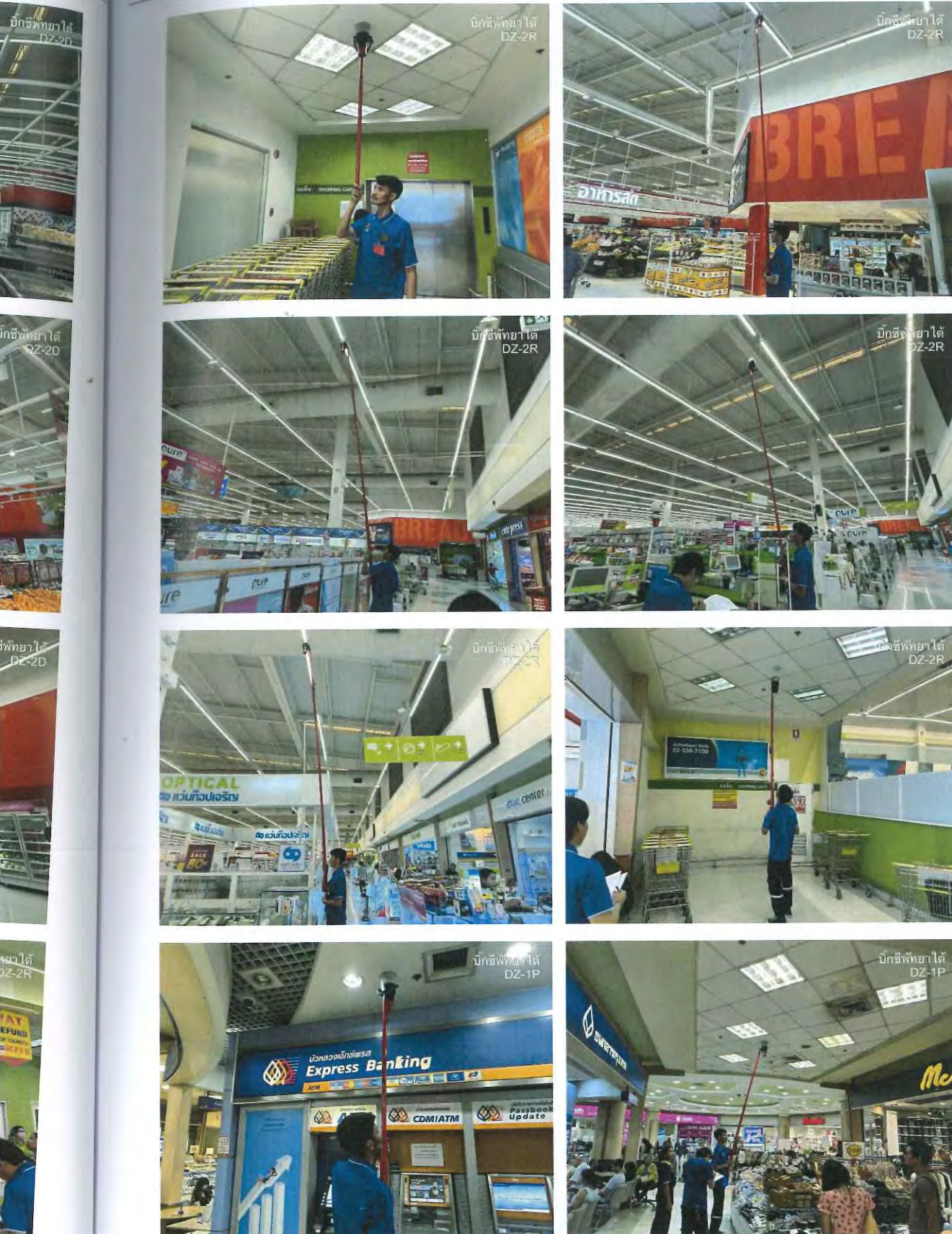
รูปที่ 2.30 ทดสอบ Smoke Detector พื้นที่บริเวณห้างสรรพสินค้า
