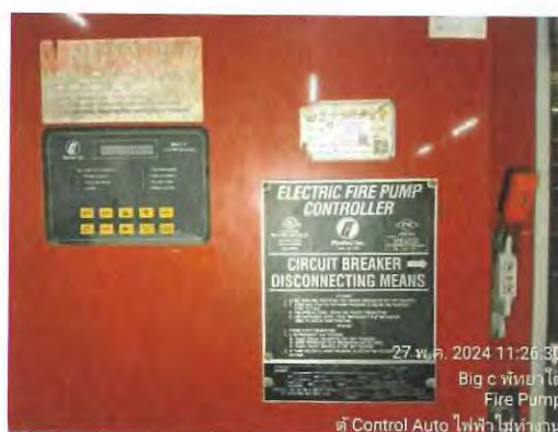
รูปที่ 3.4 ไม่มีไฟจ่ายมาที่ตู้ควบคุม
