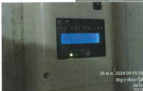
รูปที่ 2.101 ทดสอบ Gas detector , Gas controller และ Shut off valve พื้นที่ร้านผิด ไท กลาง
