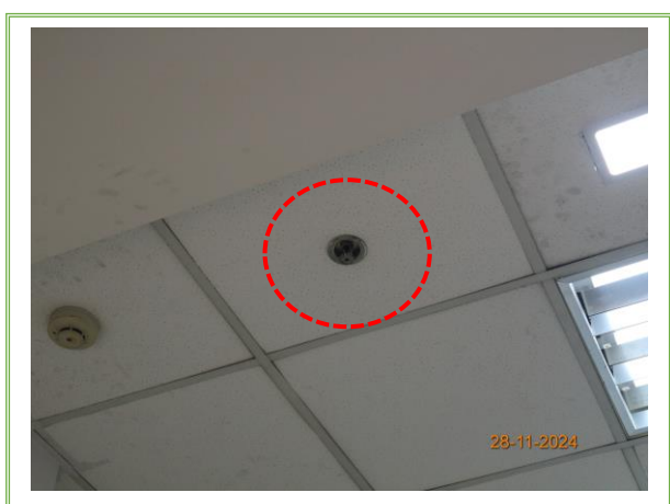
รูปที่ 3-27 Sprinkler
