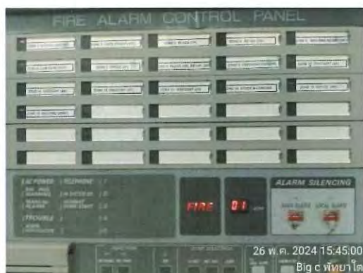
รูปที่ 2.79 ตู้ควบคุม และตู้กราฟฟิกแสดงผลแจ้งเหตุเพลิงไหม้ zone 01(DZ-1F)
