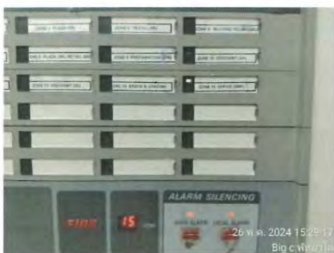
รูปที่ 2.93 ตู้ควบคุม และตู้กราฟฟิกแสดงผลแจ้งเหตุเพลิงไหม้ zone 15(DZ-2MF)
