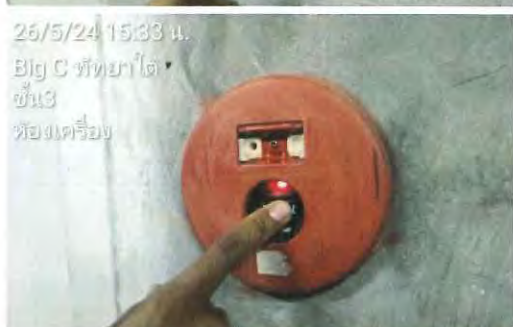
รูปที่ 2.54 ทดสอบ Manual pull station พื้นที่บริเวณหน้าห้องเครื่อง
