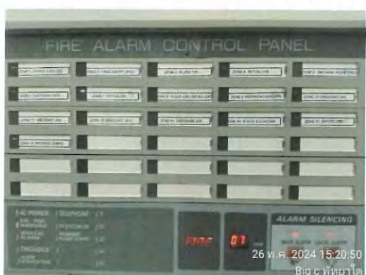
รูปที่ 2.85 ตู้ควบคุม และตู้กราฟฟิกแสดงผลแจ้งเหตุเพลิงไหม้ zone 07 (DZ-2F)
