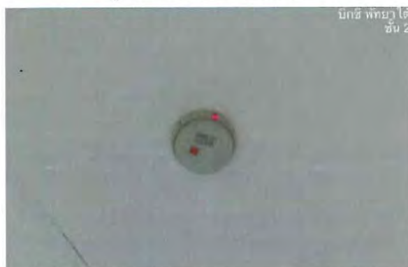
รูปที่ 1.5 Heat detector
