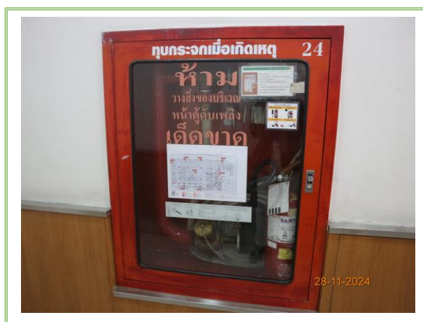
รูปที่ 3-23 ตู้สายฉีดน้ำดับเพลิง
