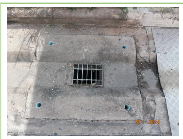
รูปที่ 3-4 ช่องระบายน้ำและตะแกรงดักขยะ
