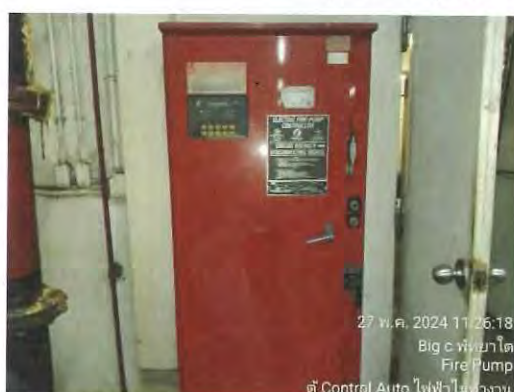
รูปที่ 3.4 ไม่มีไฟจ่ายมาที่ตู้ควบคุม
