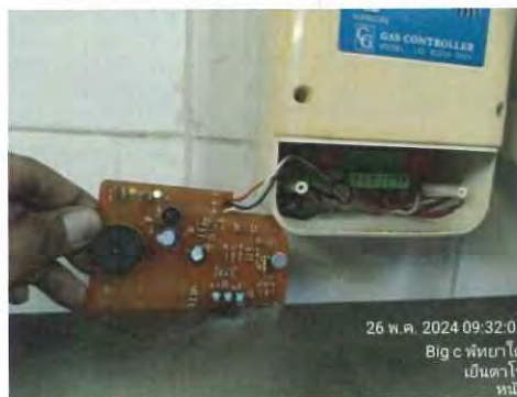
รูปที่ 2.102 ทดสอบ Gas controller และ Shut off valve พื้นที่ร้านเบ็นตาไฟ หน้า
