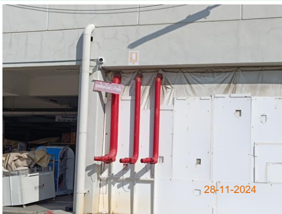
หัวรับน้ำดับเพลิงติดตั้งด้านข้างอาคาร
