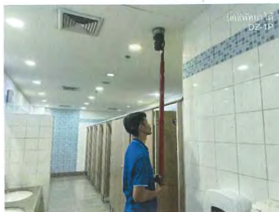
รูปที่ 2.36 ทดสอบ Smoke Detector พื้นที่บริเวณห้องน้ำหญิง
