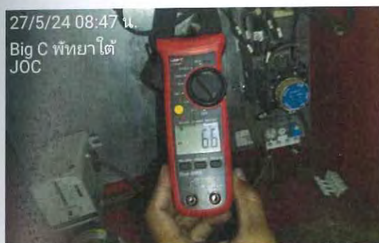
รูปที่ 2.7 ตรวจสอบและทำความสะอาดตู้ควบคุมของเครื่องสูบน้ำรักษาแรงดัน Jockey Pump
