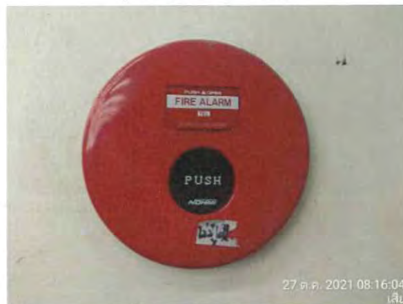
รูปที่ 1.6 Manual pull station
