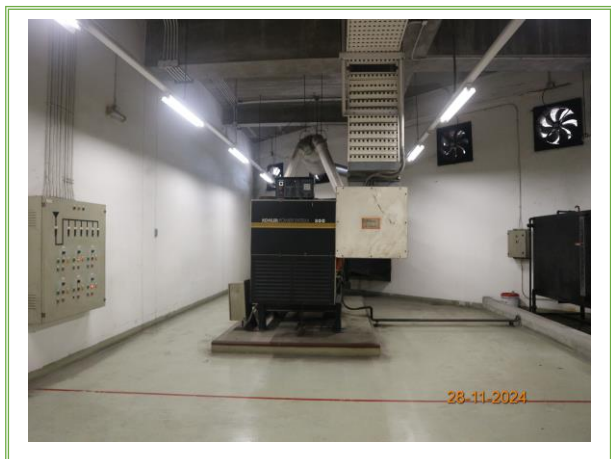
รูปที่ 3-18 เครื่องกำเนิดไฟฟ้าสำรอง
