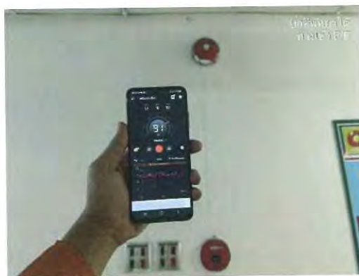
รูปที่ 2.70 ทดสอบ Alarm Bell พื้นที่บริเวณทางเข้าเฟรสฟู้ด และ วัดค่าเสียงได้ที่ 91
