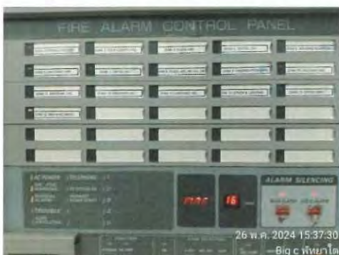
รูปที่ 2.94 ตู้ควบคุม และตู้กราฟฟิกแสดงผลแจ้งเหตุเพลิงไหม้ zone 16 (DZ-2MMC)
