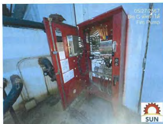
รูปที่ 2.2 ตรวจสอบและทำความสะอาดตู้ควบคุมของเครื่องสูบน้ำดับเพลิง
