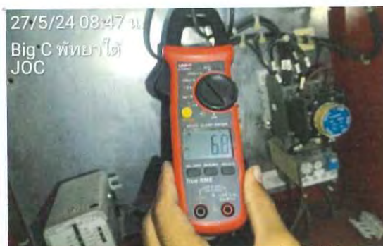
รูปที่ 2.7 ตรวจสอบและทำความสะอาดตู้ควบคุมของเครื่องสูบน้ำรักษาแรงดัน Jockey Pump
