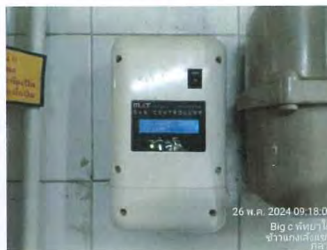
รูปที่ 2.103 ทดสอบ Gas controller และ Shut off valve พื้นที่ร้านข้าวแกงเล้งแซบ กลาง
