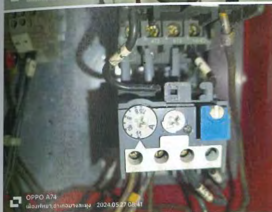
รูปที่ 2.7 ตรวจสอบและทำความสะอาดตู้ควบคุมของเครื่องสูบน้ำรักษาแรงดัน Jockey Pump
