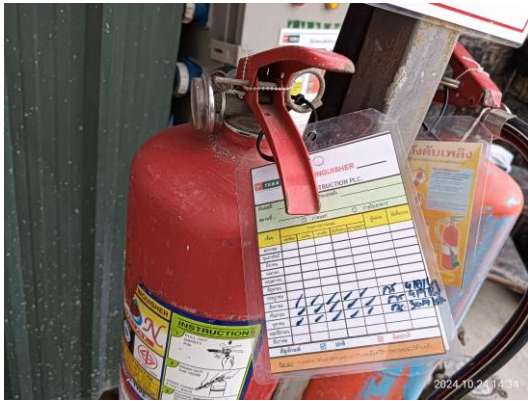
รูปที่ 3-73 การตรวจสอบประสิทธิภาพของถังดับเพลิง
