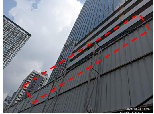
รูปที่ 3-24 ม่านลอนน้ำบริเวณแนวรั้ว Metal Sheet
