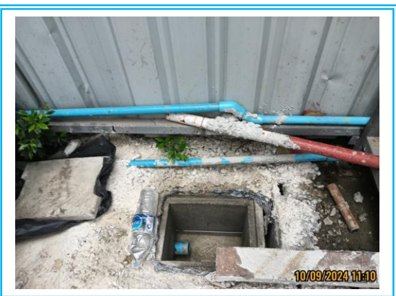
รูปที่ 3-47 ป่อพักน้ำสุดท้ายก่อนระบายลงท่อระบาย น้ำสาธารณะ
