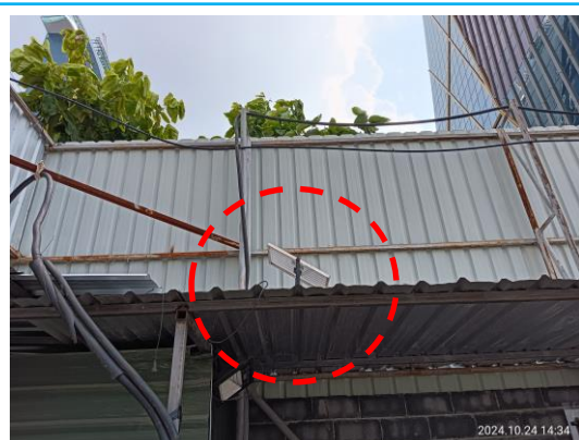
รูปที่ 3-53 ระบบโซล่าเซลล์สำหรับไฟส่องสว่างในโครงการ
