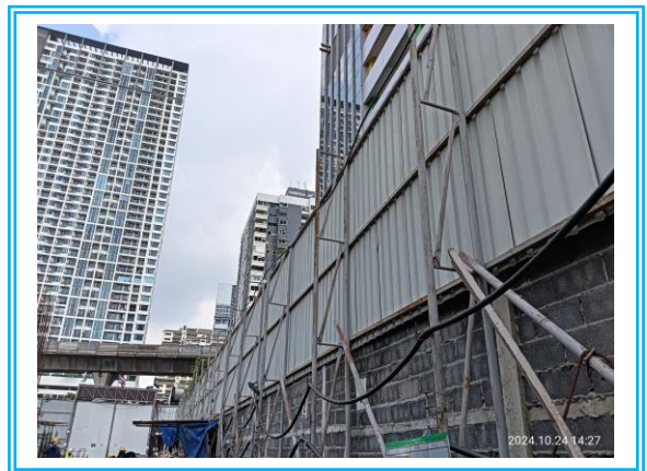
รูปที่ 3-6 รั้ว Metal Sheet ความสูง 6 เมตร โดยรอบพื้นที่ก่อสร้าง
