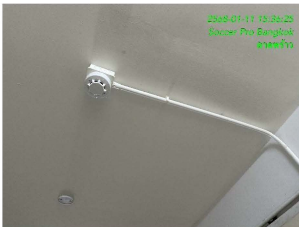
ภาพที่ 2-9 สายไฟฟ้า สายสัญญาณ อยู่ในสภาพเรียบร้อย
