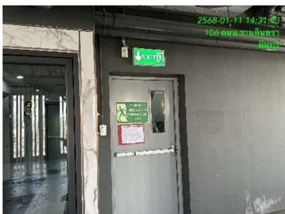
ภาพที่ 3-18 ป้ายและเครื่องหมายแสดงการหนีไฟ และแผนผังเส้นทางหนีไฟ อยู่ในสภาพดี มองเห็นได้ชัดเจน ไม่บเลือน
