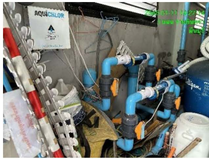
ภาพที่ 2-25 ระบบกรองน้ำของสระว่ายน้ำ ภาพที่ 2-26 การดูดตะกอน ล้างตะไคร่
