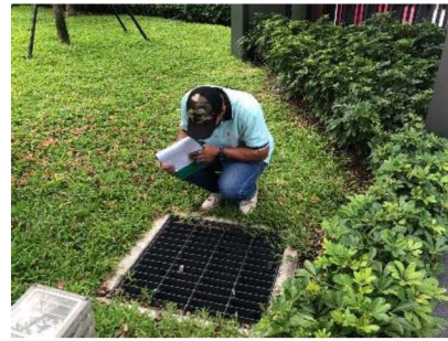
ภาพที่ 3-14 ตรวจสอบการสะสมของตะกอนดินในบ่อพักและท่อระบายน้ำ
