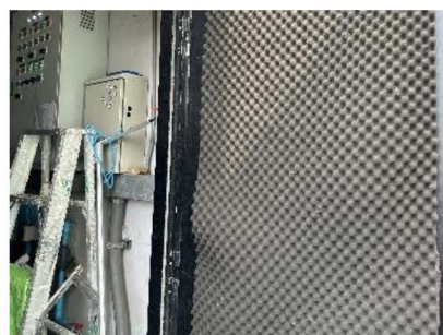
ภาพที่ 2-87 แผ่นดูดซับเสียงห้องเครื่อง สูบน้ำของสระว่ายน้ำ
