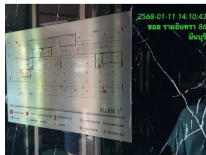
ภาพที่ 3-18 ป้ายและเครื่องหมายแสดงการหนีไฟ และแผนผังเส้นทางหนีไฟ อยู่ในสภาพดี มองเห็นได้ชัดเจน ไม่บเลือน
