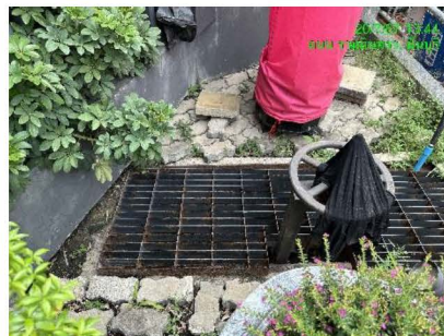
ภาพที่ 2-83 ฝาท่อระบายน้ำเป็นแบบฝาทะแกรงเหล็ก
