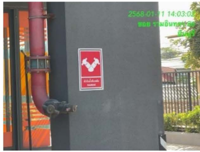
ภาพที่ 3-19 หัวรับน้ำดับเพลิงอยู่ในสภาพพร้อมใช้งานและเข้าถึงได้สะดวก
