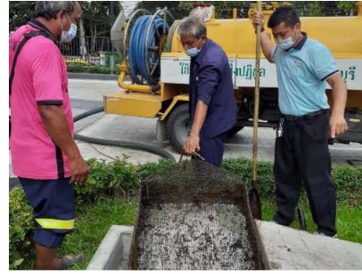
ภาพที่ 2-82 การสูบล้างปลิวและจัดเก็บกากไขมัน
