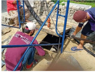
ภาพที่ 2-82 การสูบล้างปลิวและจัดเก็บกากไขมัน
