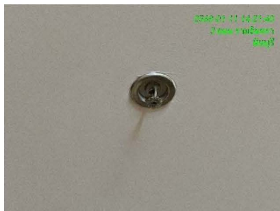
ภาพที่ 2-60 Sprinkler System
