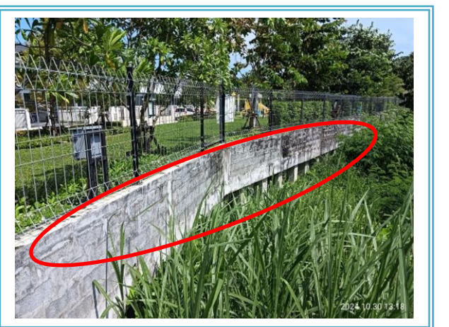
รูปที่ 3.1-4 เชือกกันดินชนิดคอนกรีตเสริมเหล็ก
