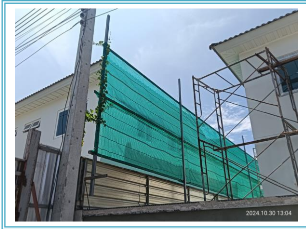
รูปที่ 3.1-11 สแลนกันฝุ่นขณะทำการก่อสร้าง
