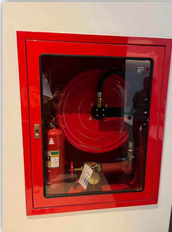
ภาพที่ 40 แสดงตู้เก็บสายน้ำดับเพลิง-ถังดับเพลิงแสดงถังดับเพลิง
