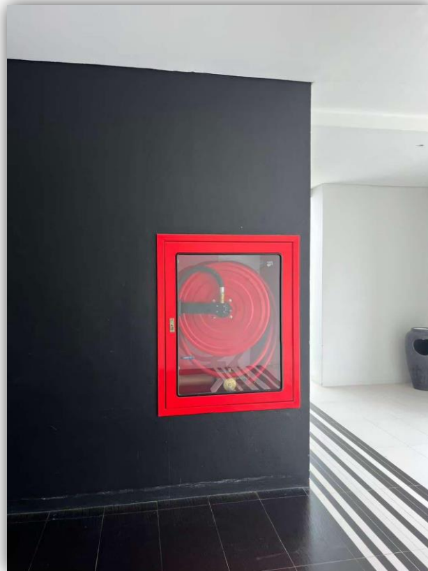
ภาพที่ 39 แสดงตู้เก็บสายน้ำดับเพลิง-ถังดับเพลิงแสดงถังดับเพลิง
