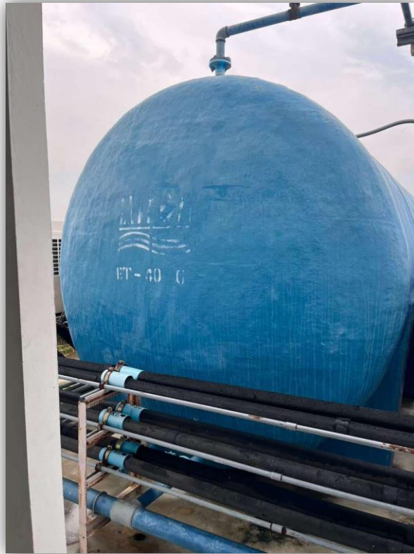
ภาพที่ 23 แสดงถังเก็บน้ำชั้นหลังคา
