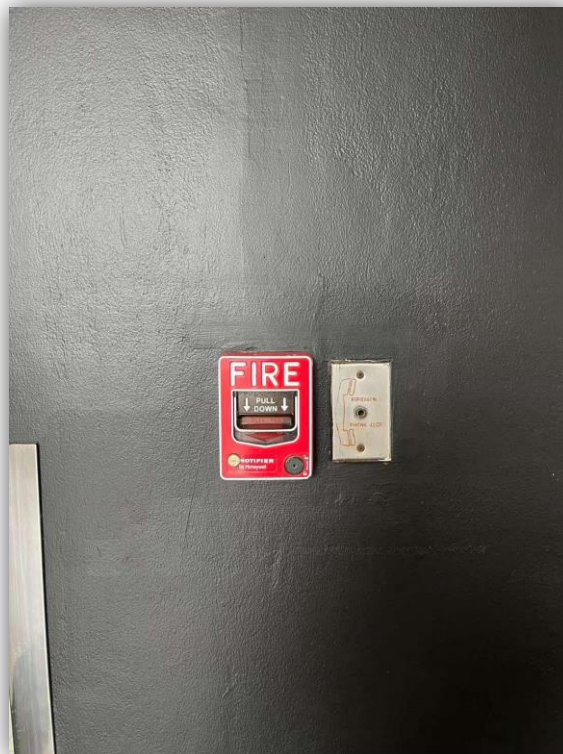
ภาพที่ 41 แสดงอุปกรณ์แจ้งเหตุเพลิงไหม้
