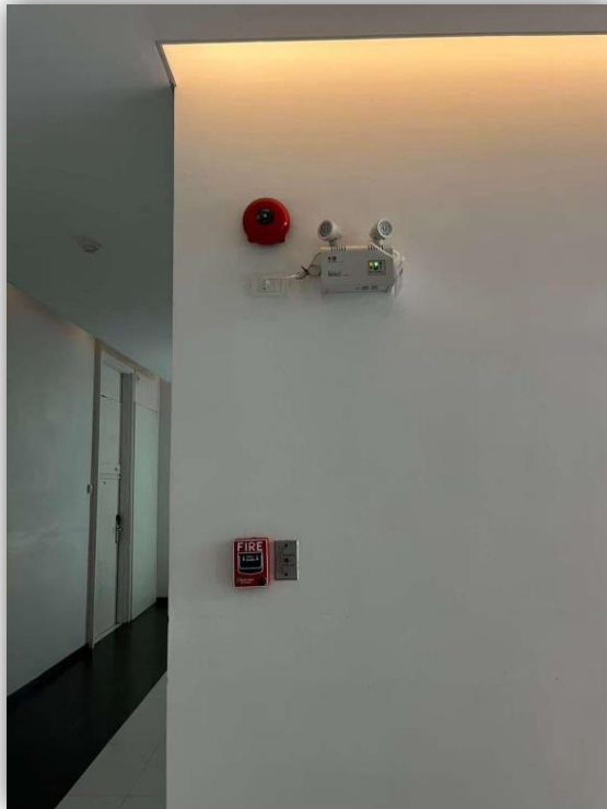
ภาพที่ 42 แสดงอุปกรณ์แจ้งเหตุเพลิงไหม้
