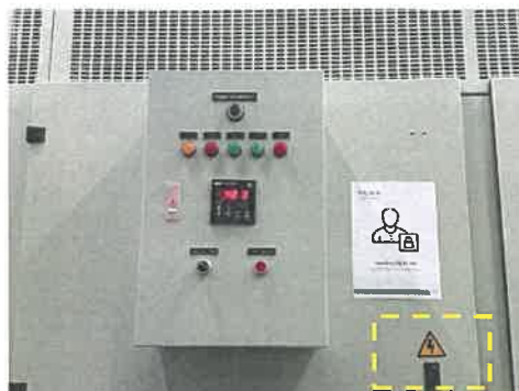
รูปที่ 21 ป้ายเตือน “อันตรายไฟฟ้าแรงสูง” ที่จุดติดตั้งหม้อแปลง
