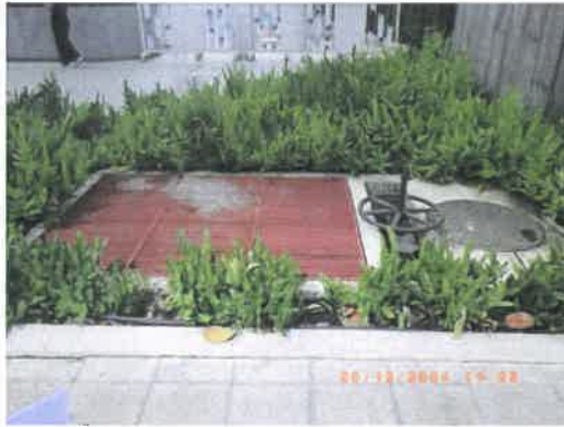
รูปที่ 11 บ่อพักขยะก่อนปล่อยระบายลงท่อสาธารณะ
