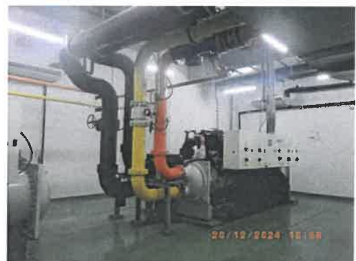
ระบบปรับอากาศ Water Cooled Chiller
