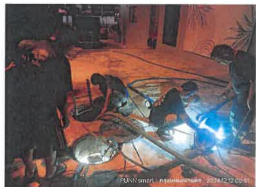
รูปที่ 9 การสูบลากตะกอนของระบบบำบัดน้ำเสีย
