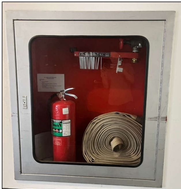
ภาพที่ 27 แสดงตู้เก็บสายน้ำดับเพลิง-ถังดับเพลิง
