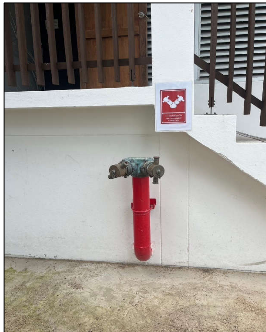
ภาพที่ 31 แสดงหัวรับน้ำดับเพลิง ฝั่งหัวหินพูลสวิต - ฝั่งบ้านพักชายทะเล
