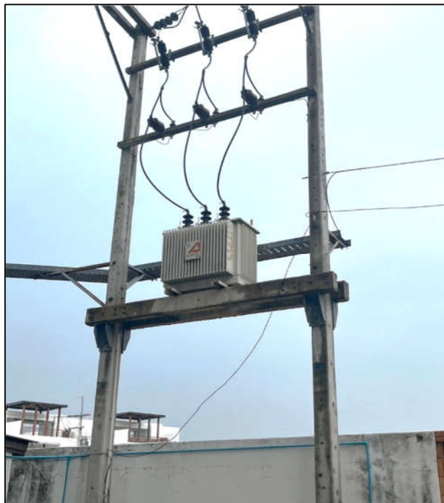
ภาพที่ 52 แสดงหม้อแปลงไฟ ฟัง โรงแรมหัวหินพูลสวิต จำนวน 1 เครื่อง
