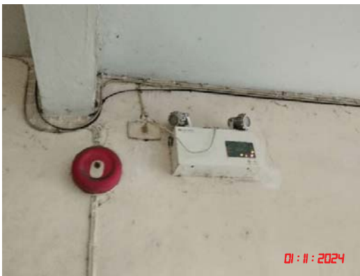
ไฟฉุกเฉินและระบบสัญญาณเตือนไฟไหม้
