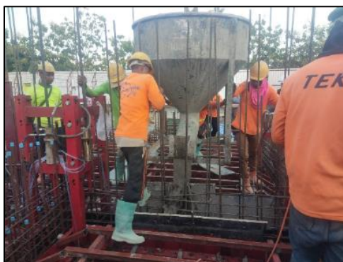
รูปที่ 77 พนักงานเทคอนกรีต
