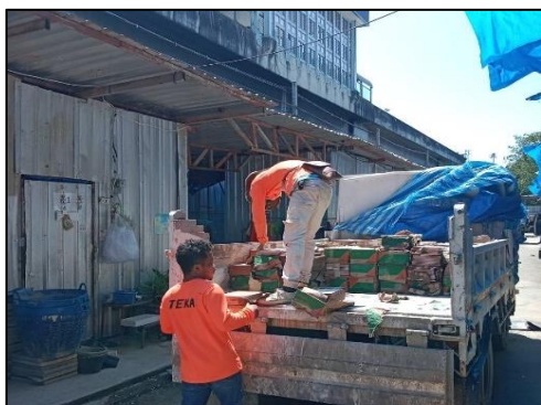
รูปที่ 92 การลงวัสดุก่อสร้างต้องกระทำด้วยความระมัดระวัง และมีวัสดุรองรับเพื่อหลีกเลี่ยงการกระแทก
