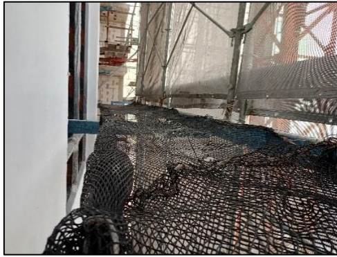
รูปที่ 95 ตะแกรงป้องกันวัสดุตกหล่นจากตัวอาคาร
