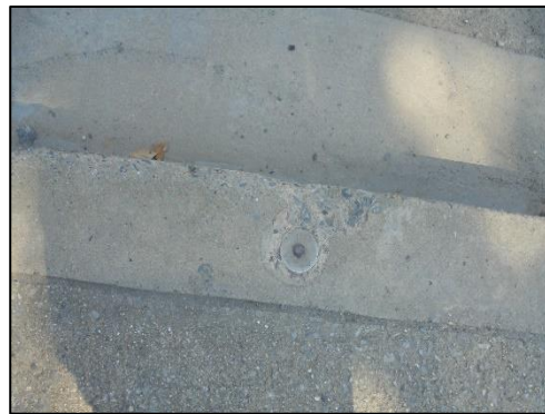
รูปที่ 72 หมุดระดับ และพิกัดอ้างอิงภายในพื้นที่ก่อสร้าง
