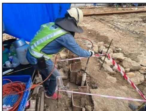
รูปที่ 46 ติดตั้งเครื่องมือตรวจวัดการเอียงตัว
