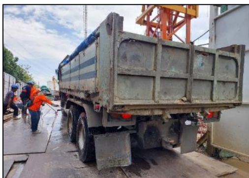
รูปที่ 123 คนงานคอยทำความสะอาดล้อรถบรรทุก
