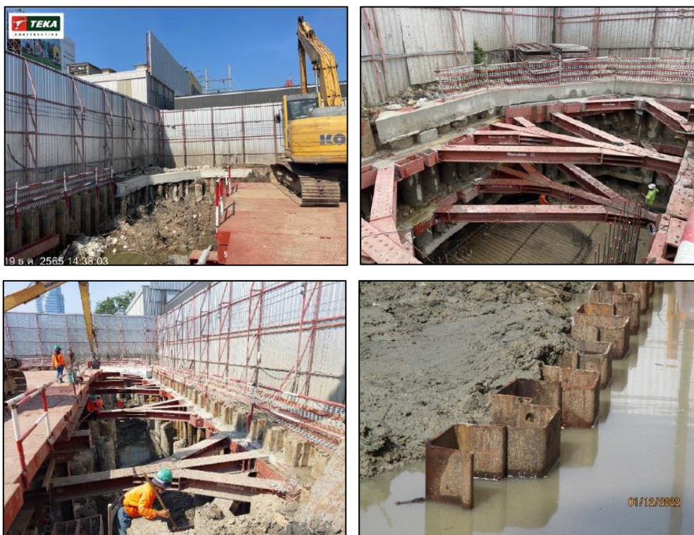
รูปที่ 41 ระบบค้ำยัน และระบบป้องกันดินพัง
