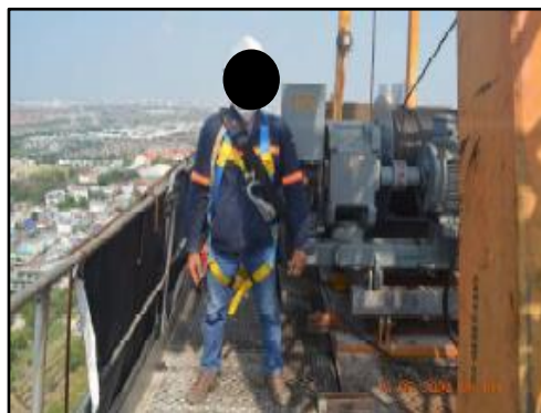
รูปที่ 109 เจ้าหน้าที่ตรวจสอบส่วนประกอบอุปกรณ์ของทาวเวอร์เครน
