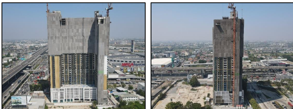
รูปที่ 5 ติดตั้ง Mesh Sheet รอบอาคาร
