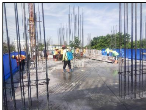
รูปที่ 81 พนักงานทำการบ่มคอนกรีต ด้วยการฉีดพ่นน้ำยา
