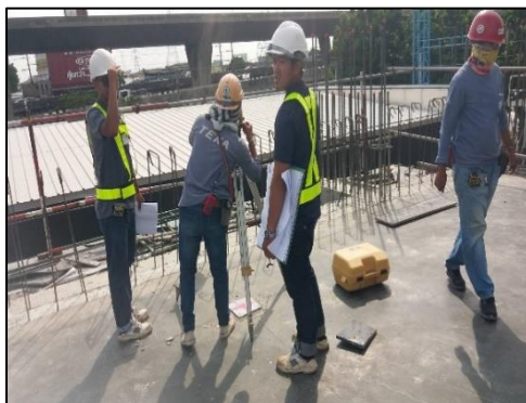
รูปที่ 75 การตรวจสอบระดับความสูงจากระดับอ้างอิงด้วยกล้องวัดมุม (Theodolite หรือ Total Station)
