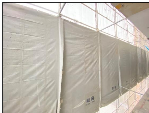
รูปที่ 25 ผนังกันเสียงแบบเคลื่อนย้ายได้
