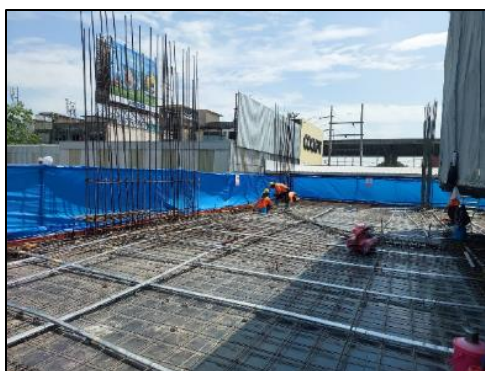
รูปที่ 76 เตรียมพื้นที่ก่อนเทคอนกรีต
