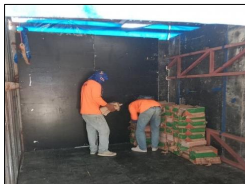
รูปที่ 92 การลงวัสดุก่อสร้างต้องกระทำด้วยความระมัดระวัง และมีวัสดุรองรับเพื่อหลีกเลี่ยงการกระแทก
