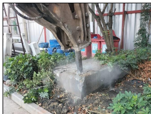
รูปที่ 127 รถขุดติดตั้งหัวสกัดคอนกรีต
