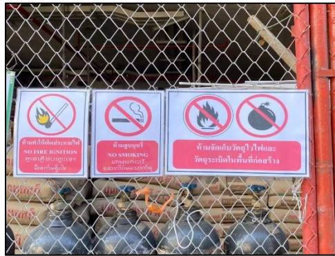
รูปที่ 83 พื้นที่จัดเก็บวัตถุไวไฟ และป้ายห้ามก่อให้เกิดประกายไฟภายในพื้นที่จัดเก็บ
