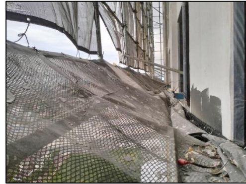
รูปที่ 95 ตะแกรงป้องกันวัสดุตกหล่นจากตัวอาคาร
