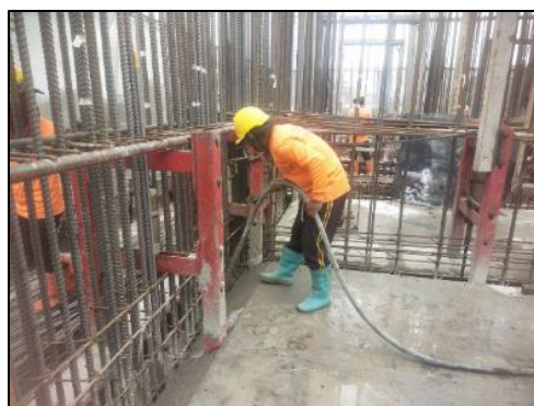
รูปที่ 80 พนักงานฉีดเชา่คอนกรีต
