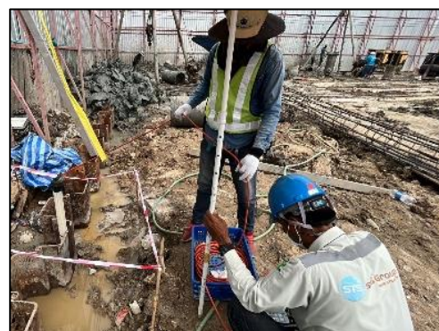
รูปที่ 46 ติดตั้งเครื่องมือตรวจวัดการเอียงตัว
