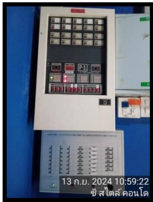
แผงควบคุม Fire Alarm
