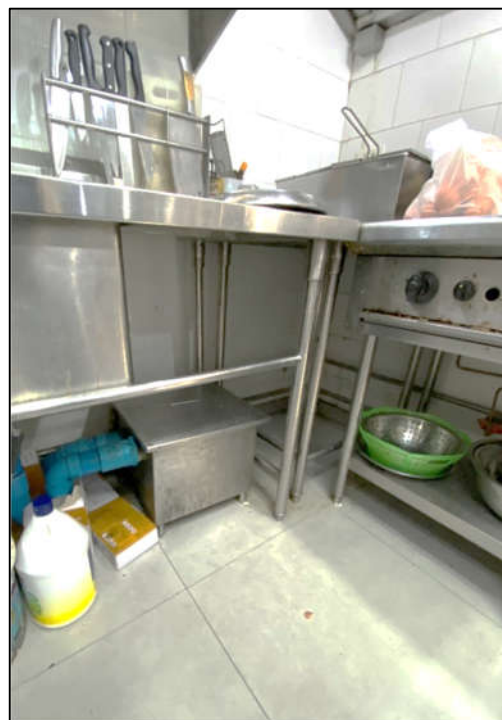
ภาพที่ 36 แสดงบ่อพักไขมันภายในห้องครัว
