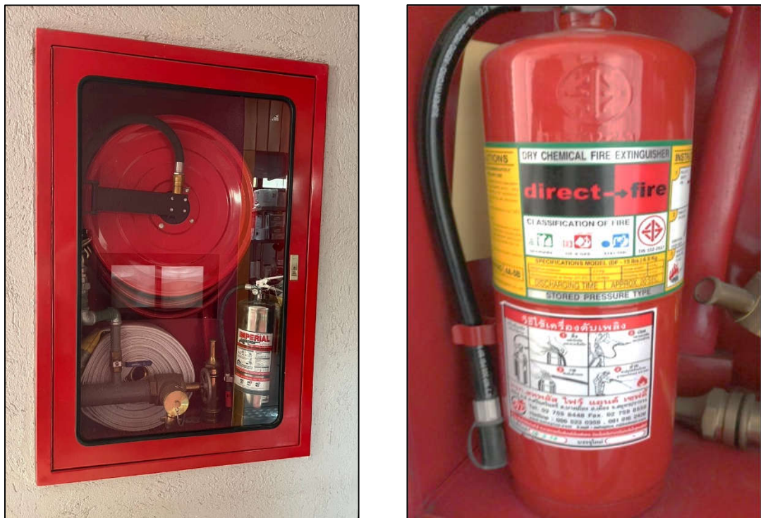
ภาพที่ 27 แสดงตู้อุปกรณ์ดับเพลิง & วิธีการใช้งาน
