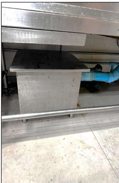
ภาพที่ 36 แสดงบ่อพักไขมันภายในห้องครัว
