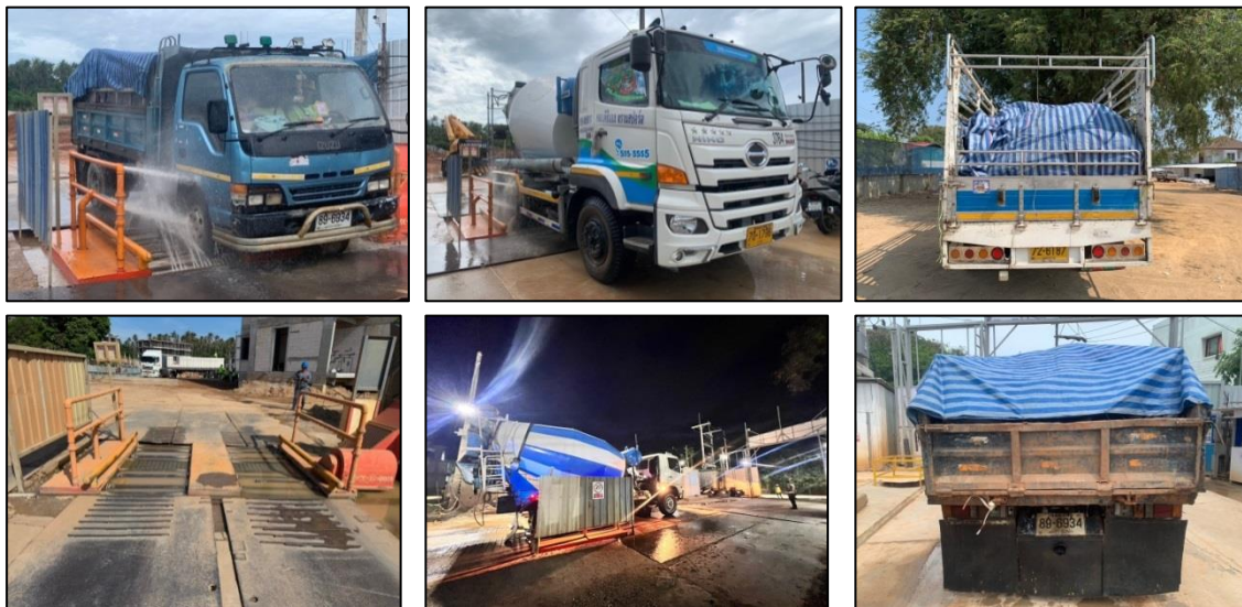
รูปที่ 3-4 การล้างล้อรถก่อนออกจากพื้นที่โครงการ
