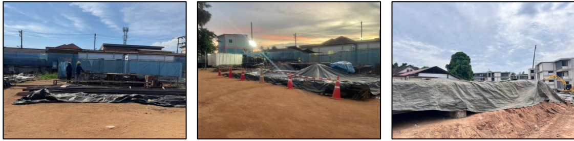
รูปที่ 3-13 ปิดหรือคลุมกองวัสดุที่มีฝุ่นหรือเศษวัสดุที่เหลือใช้ภายในพื้นที่ก่อสร้างด้วยผ้าใบ
