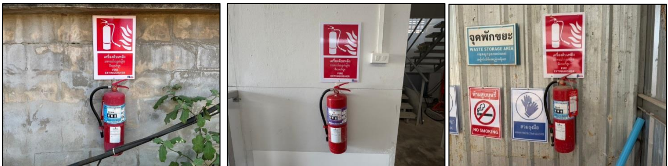
รูปที่ 3-23 ถังดับเพลิงเคมีแห้ง ขนาด 4 กิโลกรัม ภายในพื้นที่ก่อสร้าง
