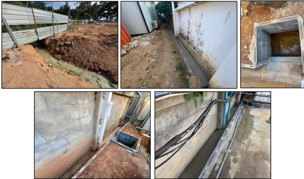
รูปที่ 3-6 รางระบายน้ำภายในโครงการ
