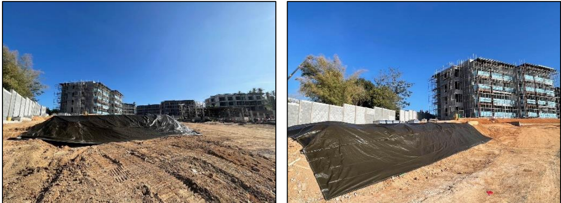
รูปที่ 3-36 ผ้าใบปิดปกคลุมบนพื้นที่ที่มีการเปิดพื้นที่ขุดดิน
