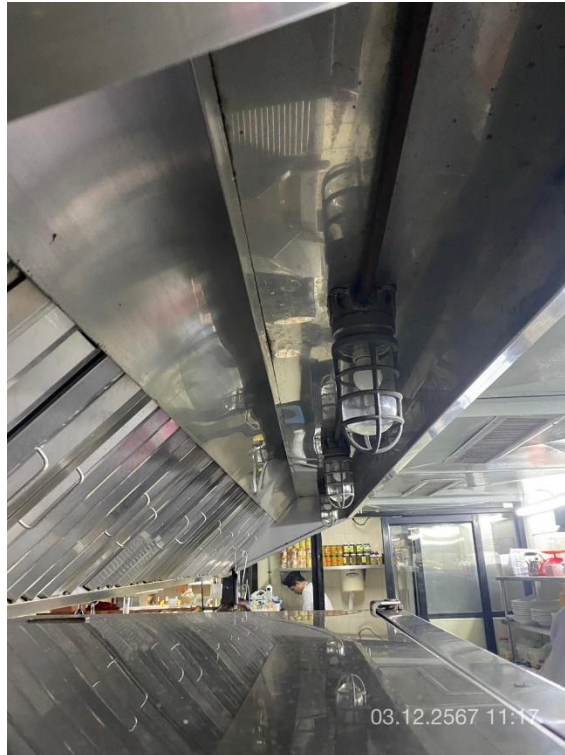
ภาพที่ 15 แสดง Hood ภายในห้องครัว
