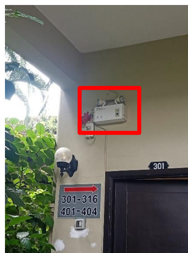
ภาพที่ 44 แสดงไฟส่องสว่างฉุกเฉิน
