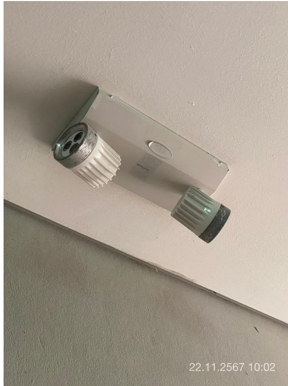
ภาพที่ 35 แสดงไฟส่องสว่างถูกฉีก
