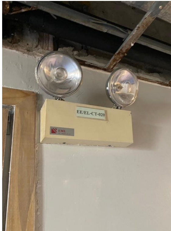
ภาพที่ 31 แสดงไฟส่องสว่างฉุกเฉินบริเวณทางเดิน
