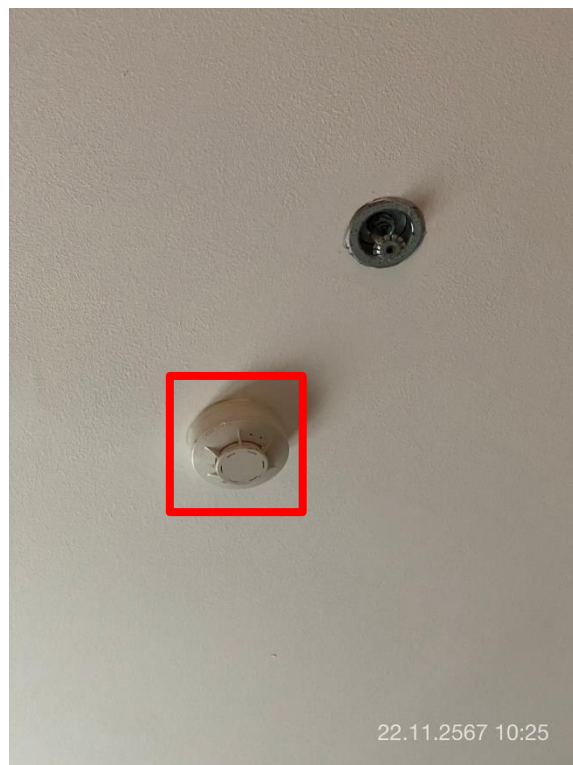
ภาพที่ 26 แสดงเครื่องตรวจจับควัน (Smoke Detector)
