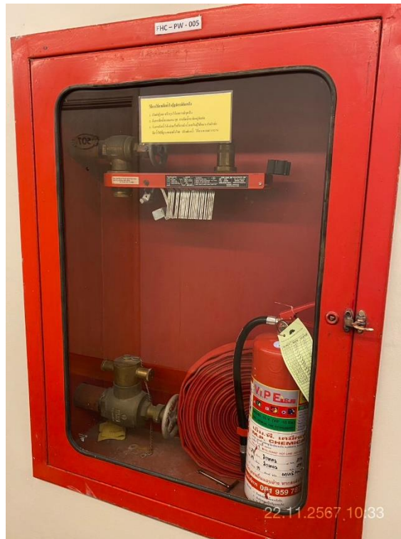
ภาพที่ 25 แสดงตู้เก็บอุปกรณ์ดับเพลิง
