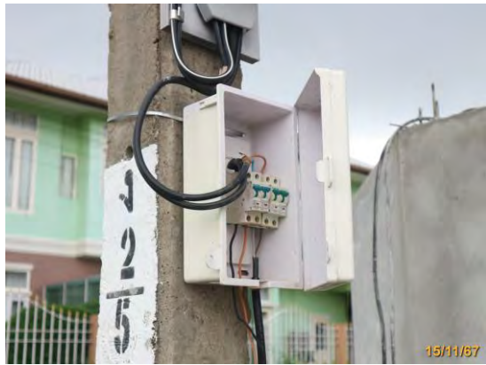
รูปที่ 3.1-15 เดินสายไฟฟ้าตามมาตรฐานกำหนด
