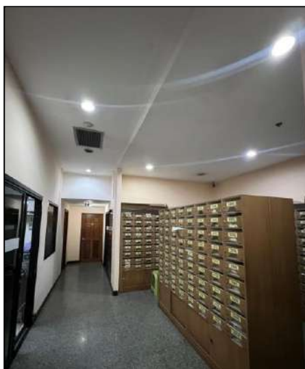
ภาพที่ 2-5 การเปลี่ยนมาใช้หลอดไฟ LED แทนหลอดตะเกียบ
