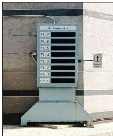
ภาพที่ 2-11 ระบบการตรวจนับช่องจอดรถในส่วนของ Plaza
