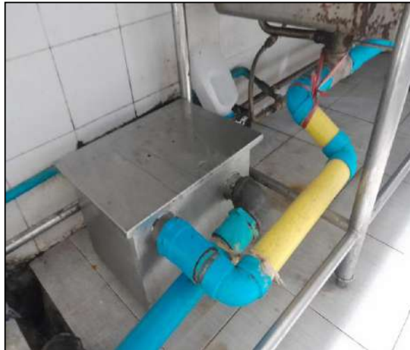
ภาพที่ 2-3 ถังดักไขมันรองรับน้ำเสียจากครัว/ร้านอาหารของโรงแรม
