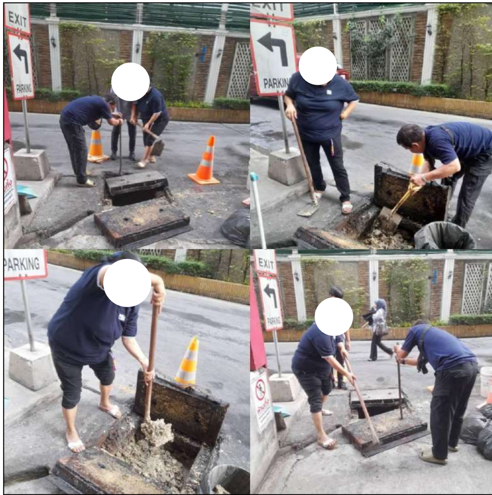
ภาพที่ 2-20 การลอกท่อระบายน้ำรอบโครงการ
