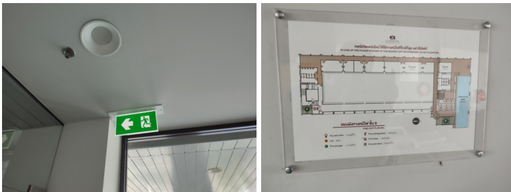
ภาพที่ 5-24 ป้ายทางหนีไฟและป้ายแบบแปลนตำแหน่งติดตั้งอุปกรณ์ดับเพลิง
