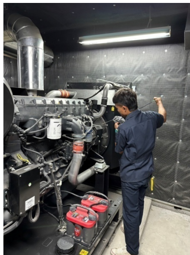
ภาพที่ 5-32 ตรวจสอบระบบไฟฟ้าและระบบไฟฟ้าสำรอง
