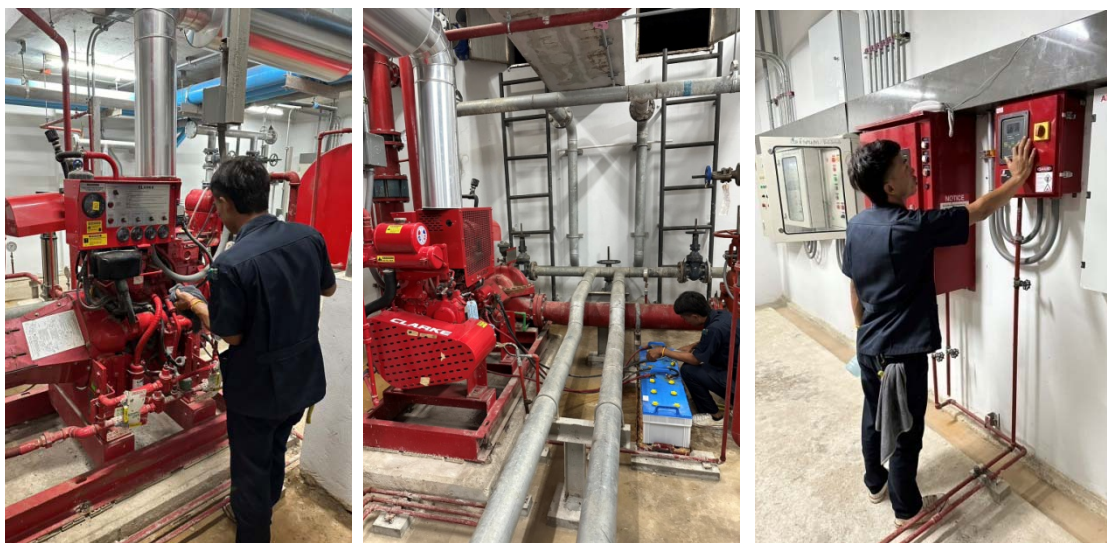
ภาพที่ 5-37 ช่วงโครงการตรวจสอบระบบ Fire Pump
