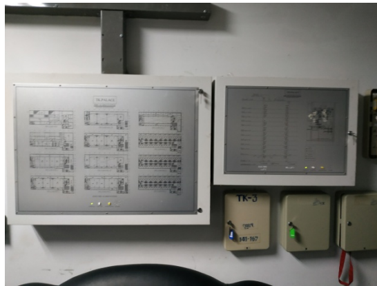
ภาพที่ 5-28 แผงควบคุมสัญญาณเตือนและแจ้งเหตุอัคคีภัย
