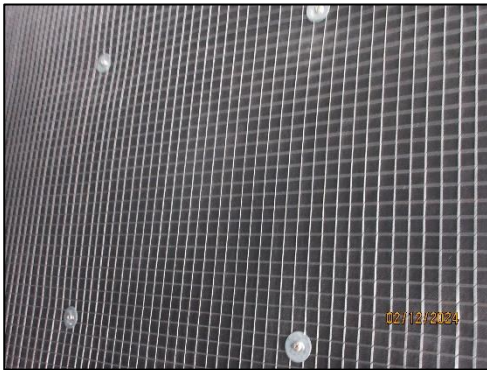
รูปที่ 39 วัสดุกันเสียงห้องเครื่องกำเนิดไฟฟ้า
