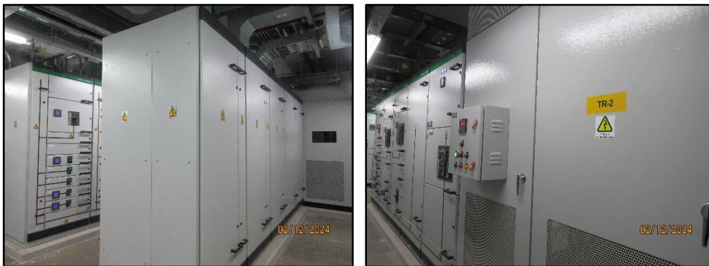
รูปที่ 1-8 หม้อแปลงไฟฟ้าแรงสูงจากการไฟฟ้านครหลวง
