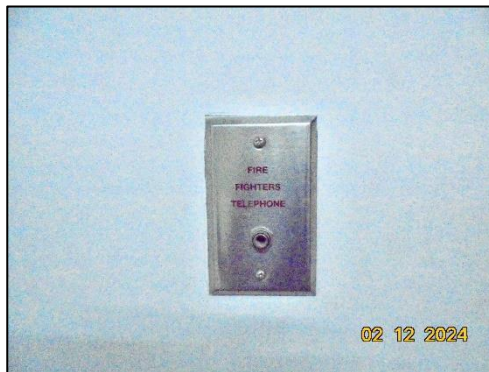
รูปที่ 63 โทรศัพท์ฉุกเฉิน (Fire Telephone Jack)
