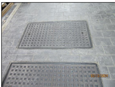
รูปที่ 8 บ่อตรวจคุณภาพน้ำก่อนออกสาธารณะ
