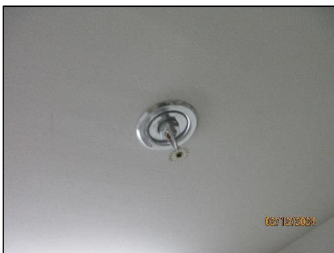
รูปที่ 86 หัวกระจายน้ำดับเพลิงภายในห้องครัว
