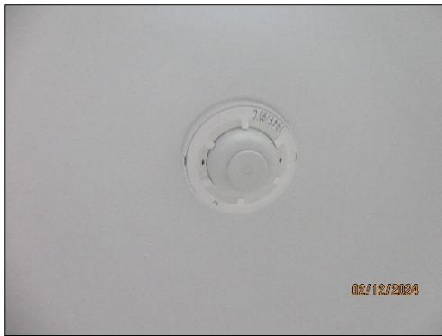
รูปที่ 58 อุปกรณ์ตรวจวัดความร้อน
