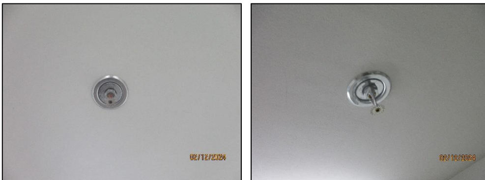
รูปที่ 52 หัวกระจายน้ำดับเพลิงอัตโนมัติ
