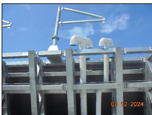
รูปที่ 10 ท่อ Vent เติมอากาศ
