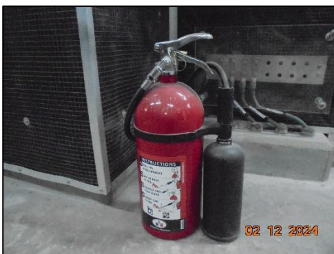
รูปที่ 50 ถังดับเพลิงมือถือชนิดคาร์บอนไดออกไซด์ (CO 2 ) ในห้องไฟฟ้า
