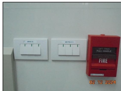
รูปที่ 42 สวิตช์ควบคุมอุปกรณ์ไฟฟ้าภายในพื้นที่โครงการ
