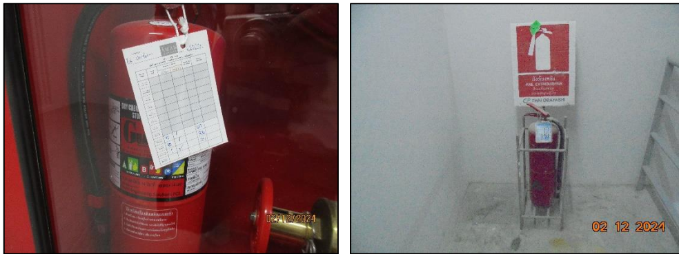
รูปที่ 51 ถังดับเพลิงชนิดผงเคมีแห้งภายในพื้นที่โครงการ
