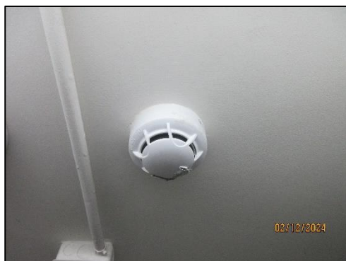
รูปที่ 57 เครื่องตรวจจับควัน
