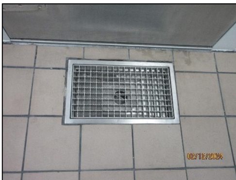
รูปที่ 85 ท่อระบายน้ำภายในห้องครัว
