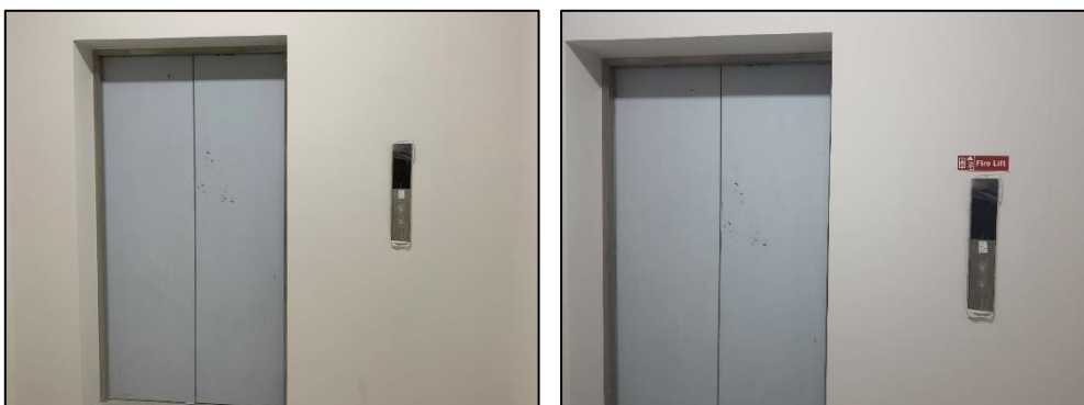
รูปที่ 53 ลิฟต์ดับเพลิง
