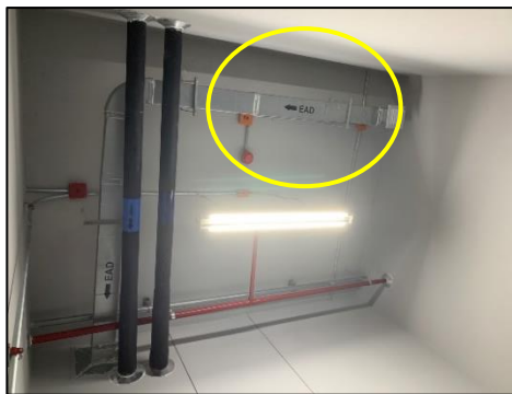
รูปที่ 36 ท่อระบายอากาศห้องขยะ
