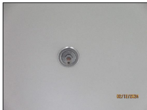
รูปที่ 86 หัวกระจายน้ำดับเพลิงภายในห้องครัว
