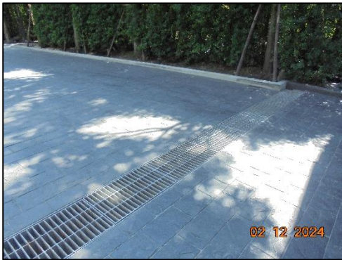
รูปที่ 88 ท่อระบายน้ำรอบพื้นที่โครงการ
