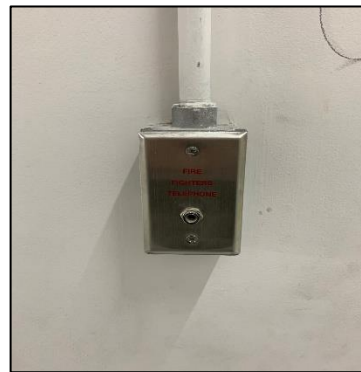
รูปที่ 63 โทรศัพท์ฉุกเฉิน (Fire Telephone Jack)
