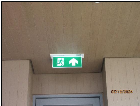
รูปที่ 55 ติดตั้งป้ายบอกทางออกฉุกเฉิน
