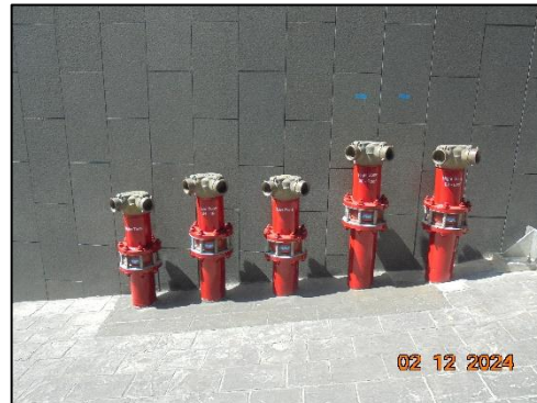
รูปที่ 48 หัวรับน้ำดับเพลิงภายนอกอาคาร
