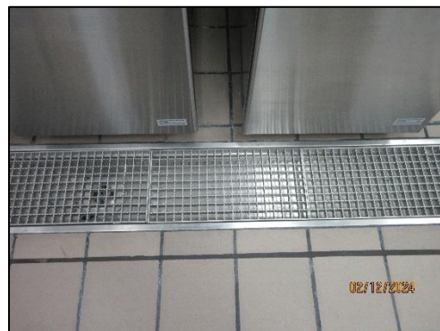
รูปที่ 85 ท่อระบายน้ำภายในห้องครัว
