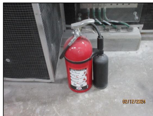
รูปที่ 50 ถังดับเพลิงมือถือชนิดคาร์บอนไดออกไซด์ (CO 2 ) ในห้องไฟฟ้า
