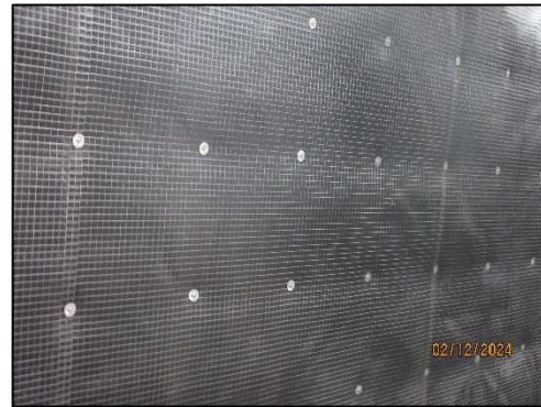
รูปที่ 39 วัสดุกันเสียงห้องเครื่องกำเนิดไฟฟ้า
