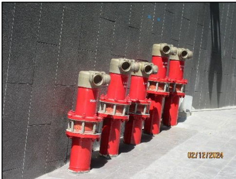
รูปที่ 48 หัวรับน้ำดับเพลิงภายนอกอาคาร
