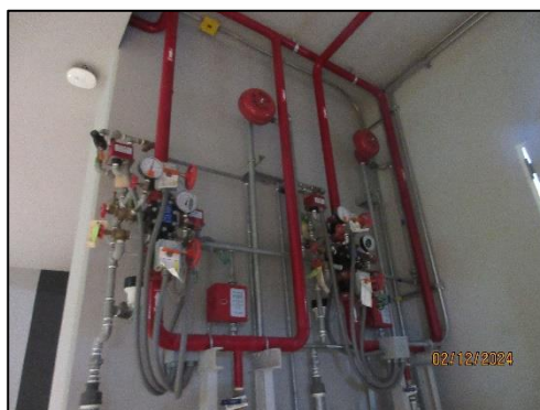
รูปที่ 60 กริ่งสัญญาณเตือนภัย
