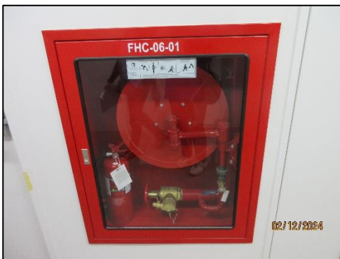
รูปที่ 49 สายฉีดน้ำดับเพลิงพร้อมอุปกรณ์ดับเพลิง
