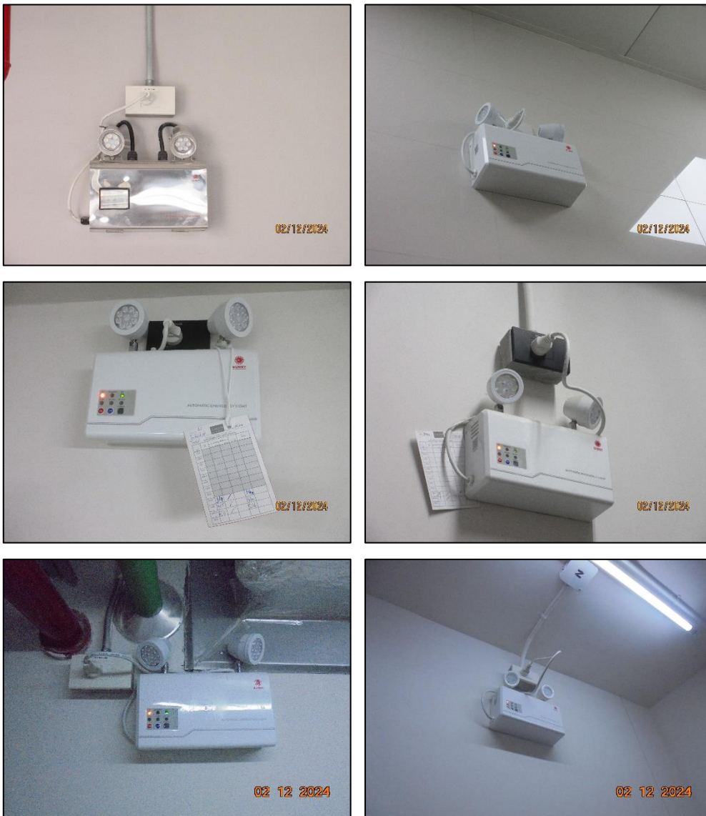
รูปที่ 67 ระบบจ่ายไฟฟ้าสำรอง
