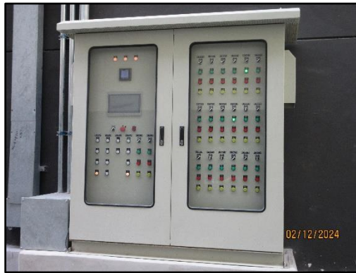
รูปที่ 1-6 ระบบมิเตอร์ไฟฟ้าสำหรับระบบบำบัดน้ำเสียของโครงการ
