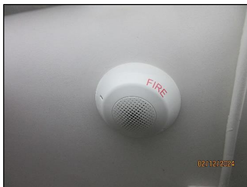
รูปที่ 61 เครื่องเตือนเพลิงไหม้ (Fire Alarm Speaker)
