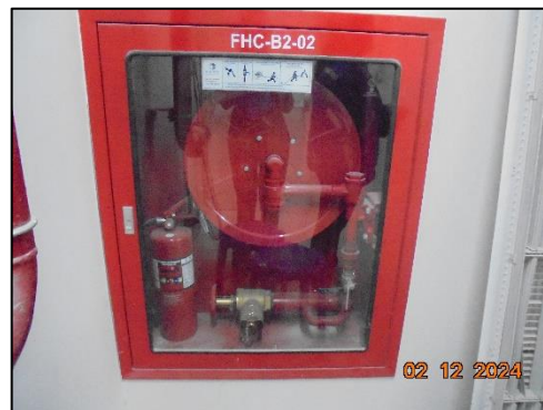
รูปที่ 49 สายฉีดน้ำดับเพลิงพร้อมอุปกรณ์ดับเพลิง
