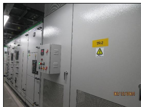
รูปที่ 37 หม้อแปลงไฟฟ้าภายในพื้นที่โครงการ
