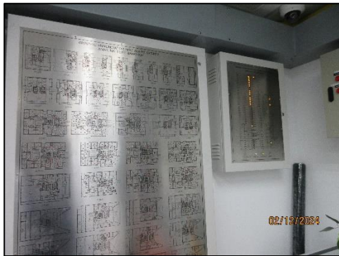
รูปที่ 62 แผงควบคุมระบบเตือนอัคคีภัย
