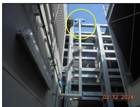
รูปที่ 10 ท่อ Vent เติมอากาศ
