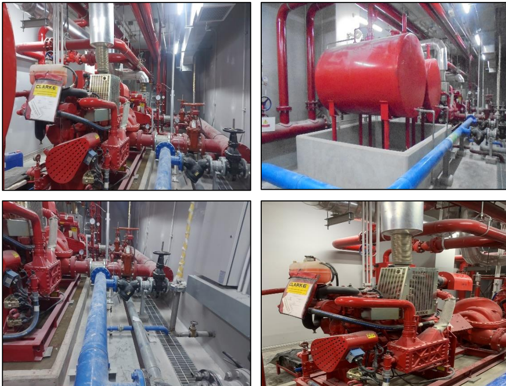
รูปที่ 46 เครื่องสูบน้ำดับเพลิงภายในพื้นที่โครงการ
