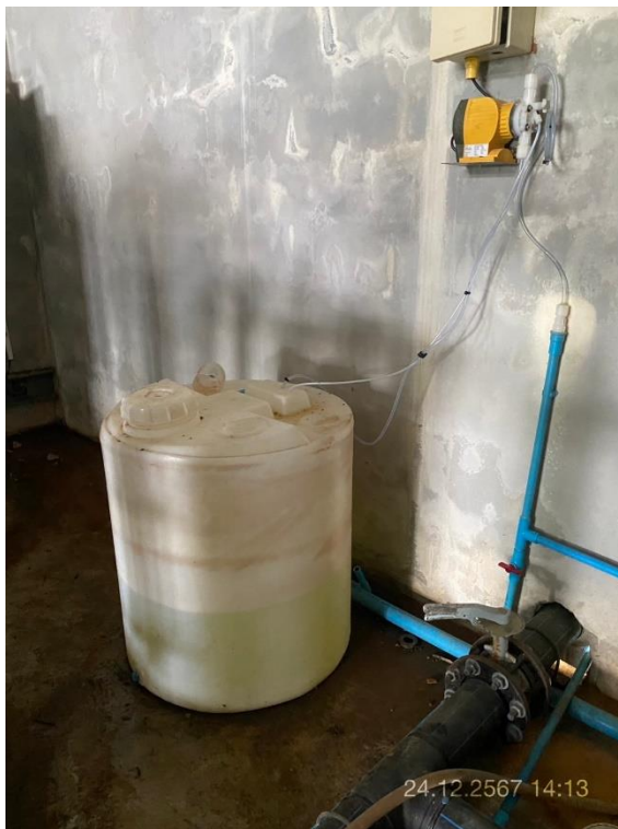
ภาพที่ 26 แสดงระบบเติมคลอรีนอัตโนมัติของระบบประปา
