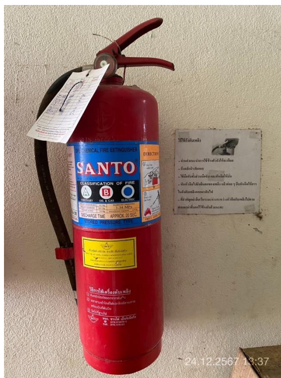
ภาพที่ 18 แสดงถังดับเพลิงชนิดผงเคมีแห้ง
