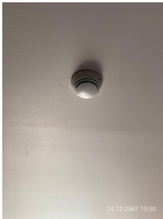
ภาพที่ 12 แสดง Smoke Detector ภายในห้องพัก
