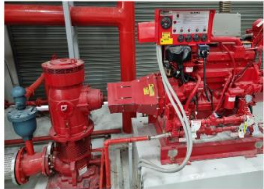
8. เครื่องสูบน้ำดับเพลิง
