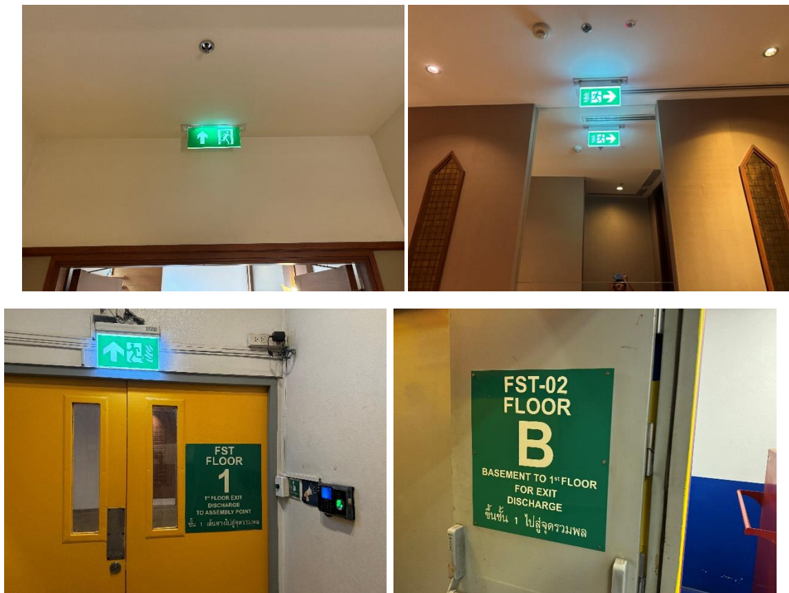
รูปที่ 3-2 ทางหนีไฟ ประตูกั้นไฟ ป้ายบอกทางหนีไฟ ทางออก
