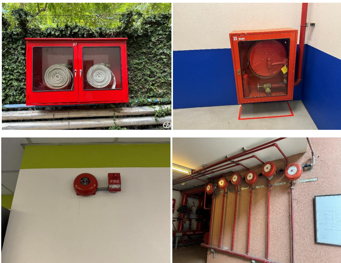
รูปที่ 3-5 การติดตั้งระบบแจ้งเหตุเพลิงไหม้ ตู้ดับเพลิงและอุปกรณ์ดับเพลิง
