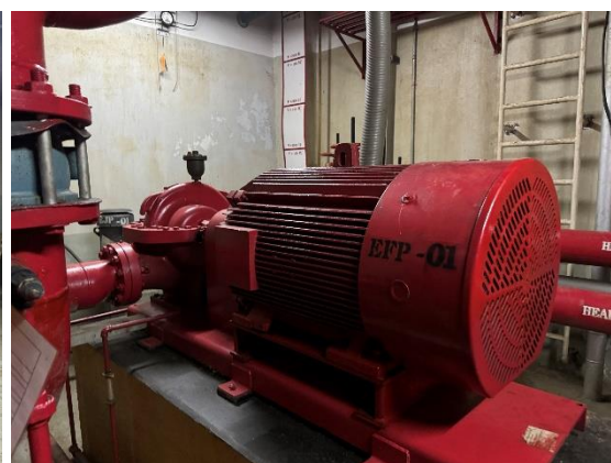
รูปที่ 3-11 เครื่องสูบน้ำดับเพลิง
