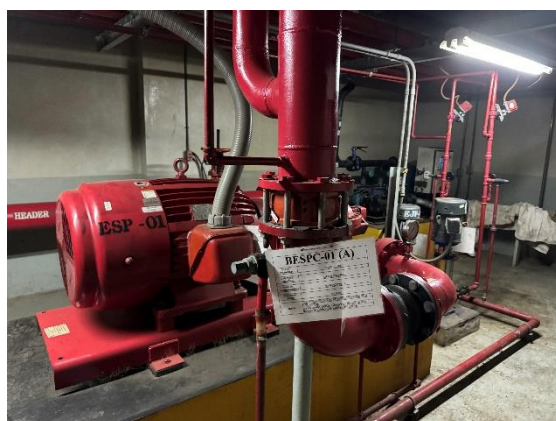
รูปที่ 3-11 เครื่องสูบน้ำดับเพลิง
