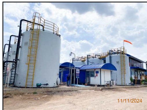
รูปที่ 2-6 ระบบ Bio scrubber ของโครงการ
