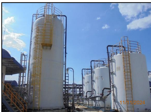
รูปที่ 2-6 ระบบ Bio scrubber ของโครงการ
