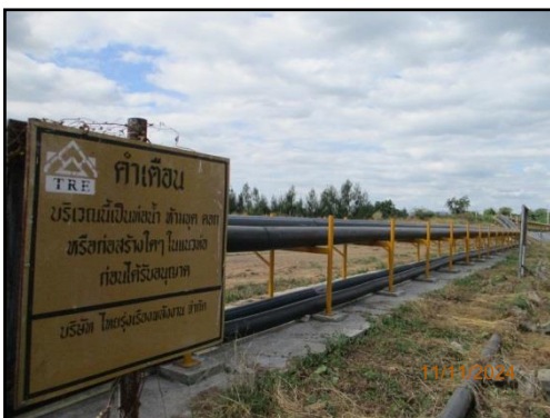
รูปที่ 2-48 ท่อที่ใช้ในการลำเลียงก๊าซชีวภาพของโครงการเป็นท่อ HDPE PE100/PN10
