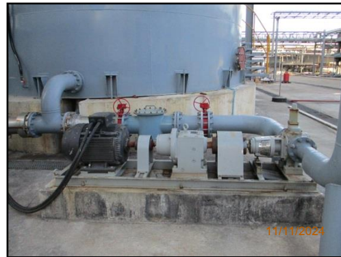
รูปที่ 2-47 ปั๊มสูบกากน้ำตาล
