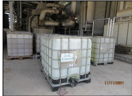
รูปที่ 2-16 ถังเก็บฟูเชออยล์
