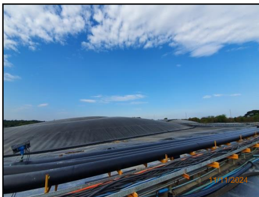
รูปที่ 2-12 ป่อหมักของระบบผลิตก๊าซชีวภาพ ของโครงการ
