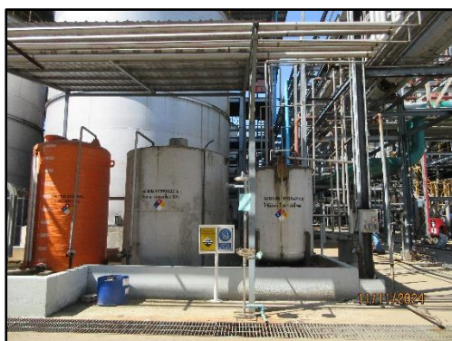
รูปที่ 2-51 ถังเก็บ NaOH
