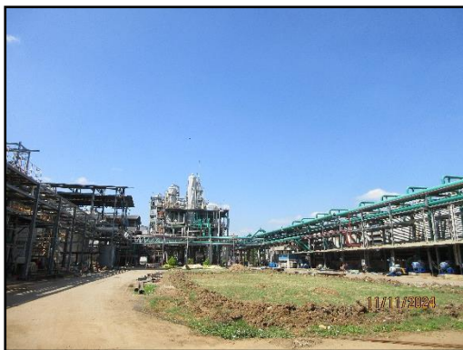
รูปที่ 2-14 ระบบขนส่งกากน้ำตาล เข้าสู่พื้นที่โครงการเพื่อใช้ในกระบวนการผลิตเป็นระบบท่อ
