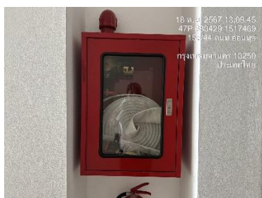
รูปที่ 32 (ต่อ) ถังดับเพลิงและตู้ดับเพลิงพร้อมสายฉีด
