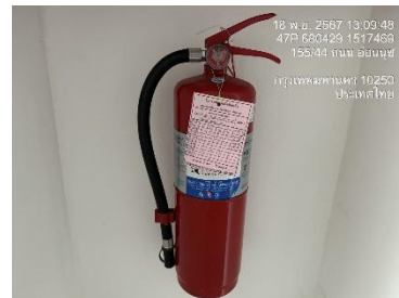
รูปที่ 32 ถังดับเพลิงและตู้ดับเพลิงพร้อมสายฉีด
