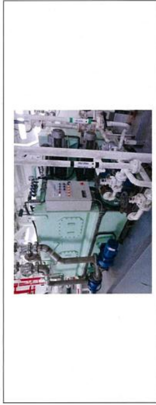
รูปที่ 6 ระบบบำบัดสิ่งปฏิกูลบนแทนเจาะ
