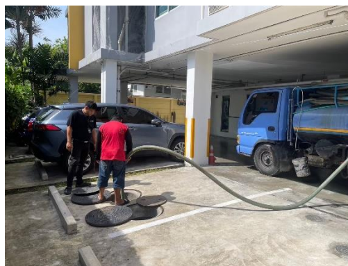
รูปที่ 7 การสูบล้างตะกอน
