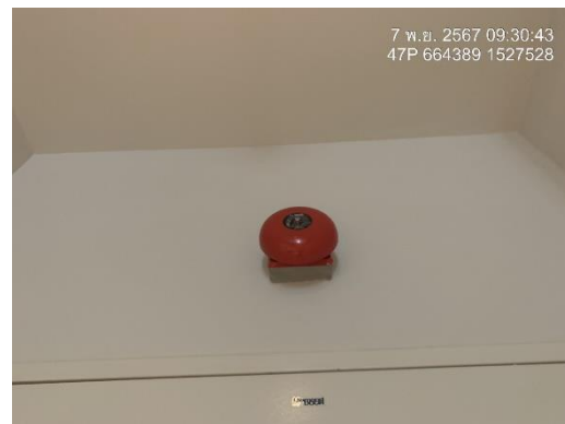
อุปกรณ์ส่งสัญญาณแจ้งเหตุแบบกริ่งสัญญาณ
