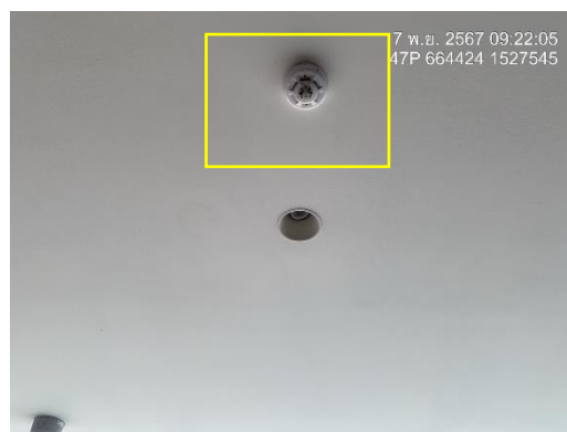
อุปกรณ์ตรวจจับควันไฟ (Smoke Detector)
