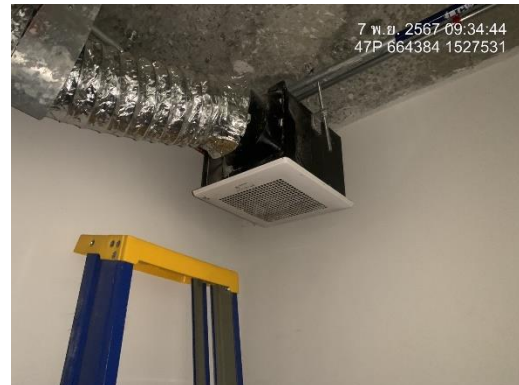
รูปที่ 17 พัดลมดูดอากาศ
