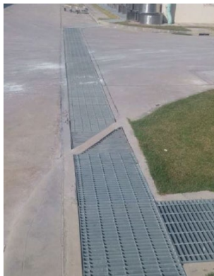
ภาพที่ 2-28 ตัวอย่างรางระบายน้ำเสียและรางระบายน้ำฝนของโรงงาน
