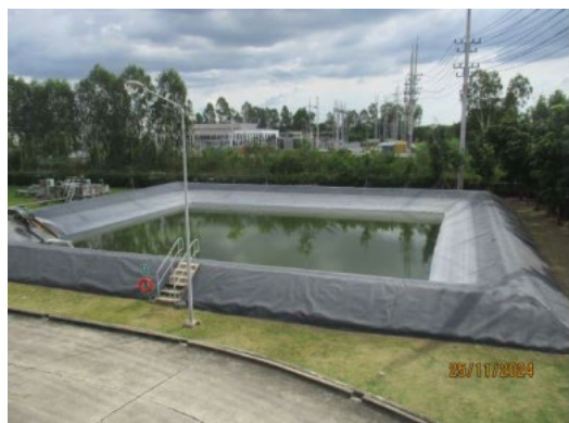
ภาพที่ 2-13 ตัวอย่างบ่อกักน้ำทิ้งหลังการบำบัดของโรงงาน
