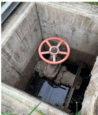
ภาพที่ 2-22 การติดตั้งวาล์วเปิด-ปิด เพื่อควบคุมการปล่อยน้ำเสียของโรงงาน
