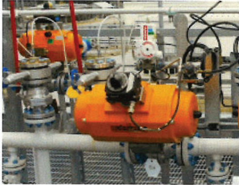
ภาพที่ 2-33 ระบบ Automatic Block Valve ของ PO
