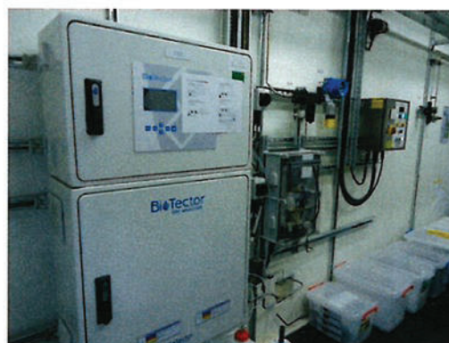
ภาพที่ 2-4 อุปกรณ์ตรวจวัดน้ำ Cooling Blow Down (TOC analyzer)
