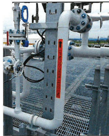
ภาพที่ 2-30 ท่อส่งไนโตรเจนเข้า Pad ถังเก็บกาก
