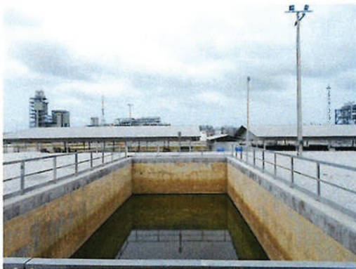
ภาพที่ 2-9 บ่อพักน้ำฝนของโรงงานผลิตสาร โพรพิลีนไกลคอล
