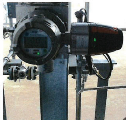
ภาพที่ 2-32 Flow Meter ของถังปฏิกริยา
