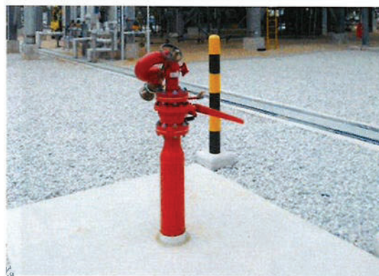
ภาพที่ 2-22 Fire Monitor Gun
