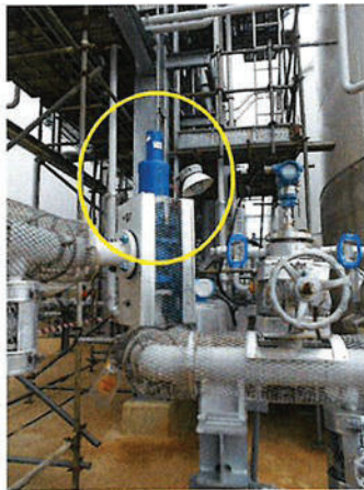
ภาพที่ 2-29 อุปกรณ์ระบายความดันของถังเก็บ ผลิตภัณฑ์ (PSV)
