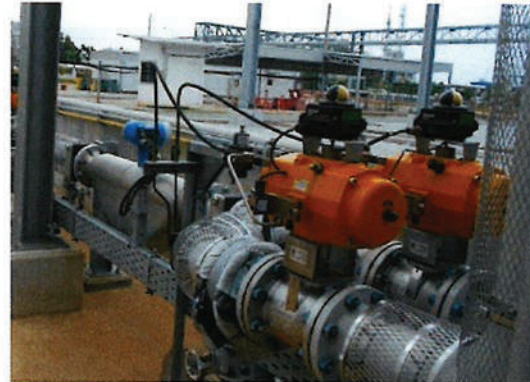
ภาพที่ 2-34 อุปกรณ์ตรวจวัดในเส้นท่อ และ Isolate Valve
