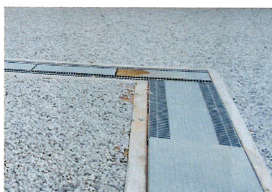
ภาพที่ 2-6 รางระบายน้ำในพื้นที่ก่อนลงสู่บ่อหน่วงน้ำ
