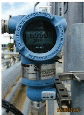
ภาพที่ 2-31 อุปกรณ์ตรวจวัดอุณหภูมิและความดัน
