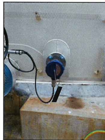
ภาพที่ 2-35 อุปกรณ์ตรวจวัดอุณหภูมิของถังผลิตภัณฑ์
