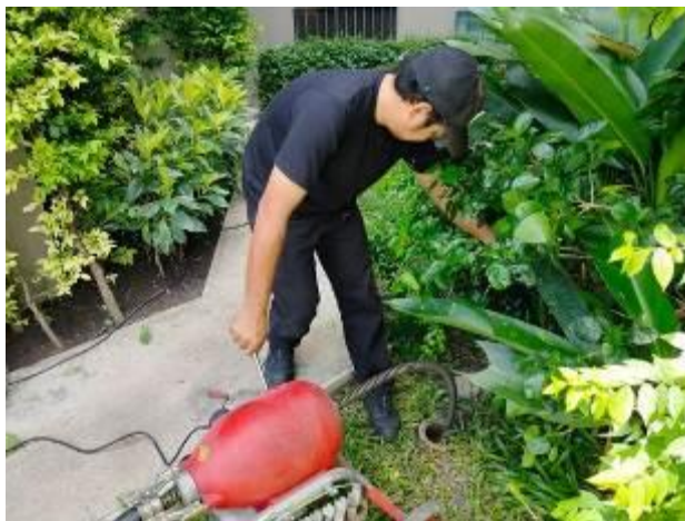
ช่างอาคารดำเนินการแก้ไขท่อน้ำที่ตัน บริเวณอาคาร C
