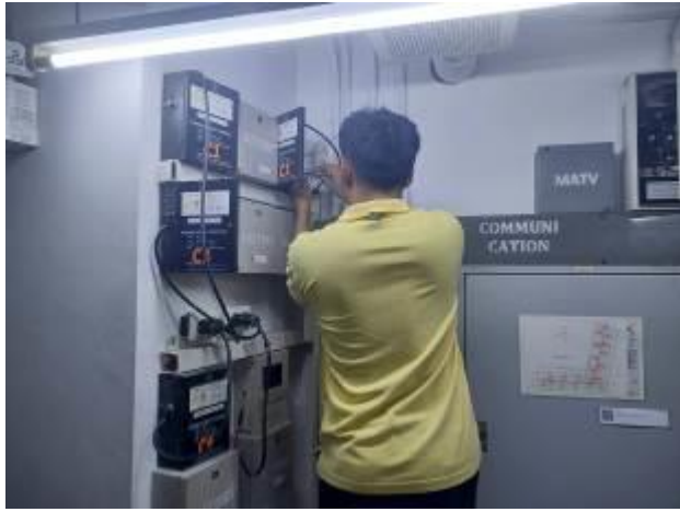
ช่างอาคารดำเนินการเปลี่ยน Power Supply บริเวณประตูเข้า-ออก ชั้น 1 อาคาร C
