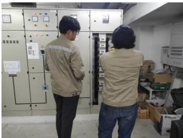
เจ้าหน้าที่การไฟฟ้าเข้าเทอร์โมสแกนหม้อแปลงและตู้ MDB อาคาร A B และอาคาร C
