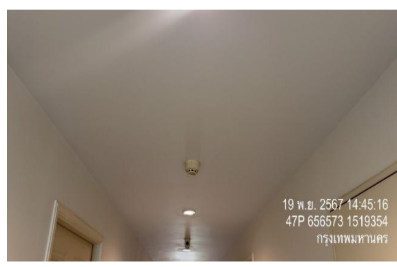
รูปที่ 35 อุปกรณ์ตรวจจับควันอัตโนมัติ
