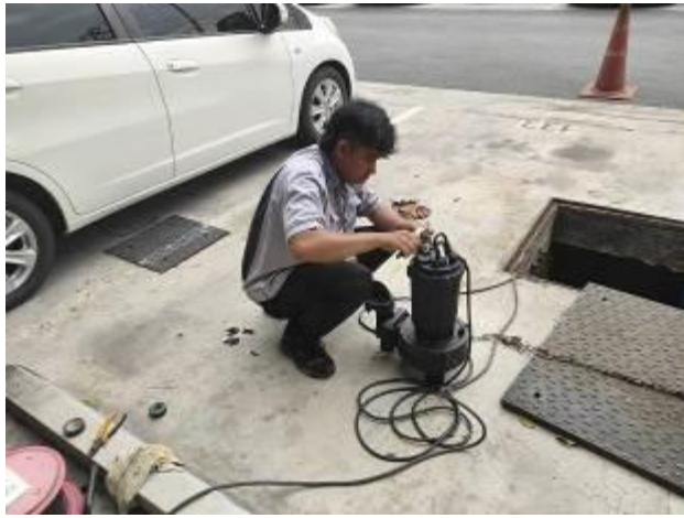
ช่างอาคารฯ ดำเนินติดตั้งปั๊มเติมอากาศ อาคาร A (ดำเนินการส่งซ่อมเนื่องจากขดลวดไหม้)
