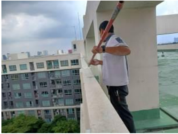
ช่างอาคารฯ ดำเนินการยิงซิลิโคนขอบเฟรมหน้าต่างทางเดินส่วนกลาง รอยต่อแผ่นพรีแคสบริเวณรอบขอบหน้าต่างทางเดินส่วนกลาง ชั้น 8 อาคารC
