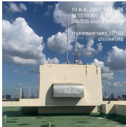
รูปที่ 20 ถังเก็บน้ำบนชั้นหลังคา
