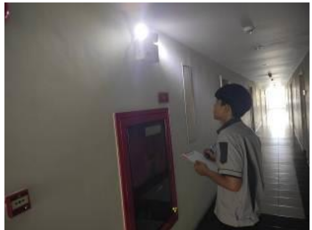
ช่างอาคารฯ ดำเนินการตรวจสอบเช็คระบบไฟฉุกเฉิน (Emergency light) (ตามแผนงาน)
