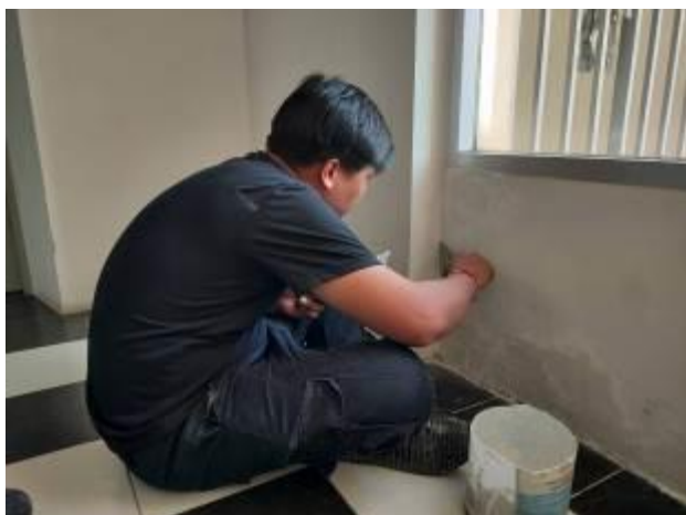
ช่างอาคารฯ ดำเนินการแก้ไขสีหลุดร่อน เนื่องจากน้ำรั่วซึม บริเวณหน้าต่างหน้าลิฟต์ชั้น 8 อาคาร B
