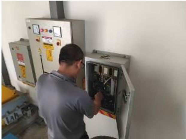
ช่างลิฟต์ดำเนินการเปลี่ยนแบตเตอรี่ ARD ระบบลิฟต์
