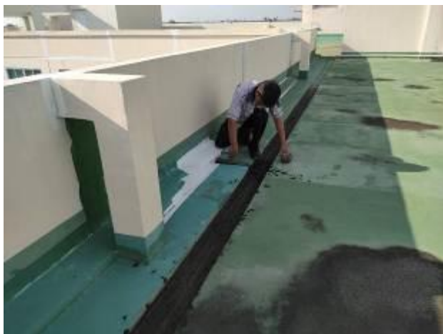
ช่างอาคารฯ ดำเนินการตรวจสอบและทำความสะอาดรางระบายน้ำดาดฟ้า อาคาร A B และอาคาร C (ตามแผนงาน)
