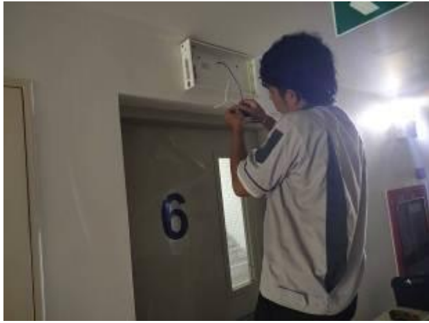
ช่างอาคารฯ ดำเนินการเปลี่ยนป้ายไฟทางออกฉุกเฉินที่ชำรุด (Exit Light) อาคาร A B และอาคาร C
