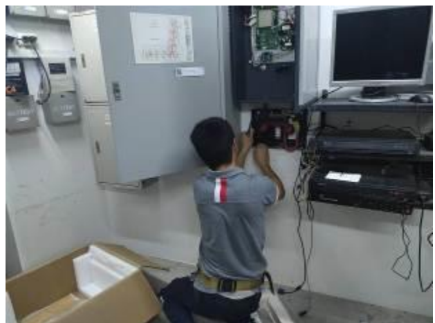
ผู้รับเหมาบริษัท มาสเตอร์ คอนโทรล เข้าดำเนินการเปลี่ยนตู้ Fire Alarm อาคาร C เนื่องจากของเดิมชำรุด
