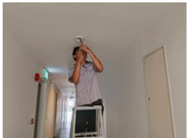
ช่างอาคารฯ ดำเนินการเปลี่ยนตัวตรวจจับควันไฟ (Smoke Detector) ที่ชำรุด
