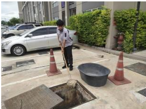
ช่างอาคารฯ ดำเนินการตักไขมัน บริเวณบ่อบำบัดน้ำเสีย อาคาร C
