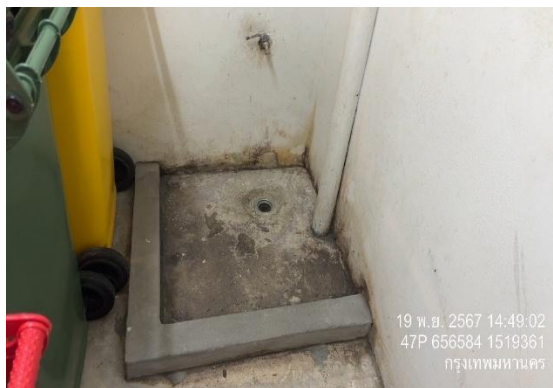
รูปที่ 29 ท่อระบายน้ำภายในห้องพักขยะ
