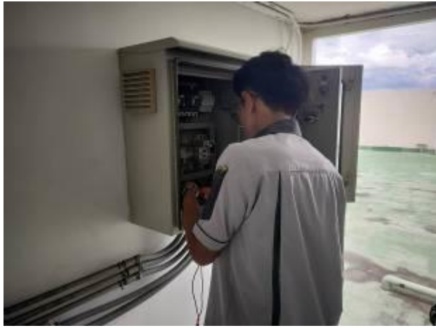
ช่างอาคารฯ ตรวจสอบระบบ Booster pump อาคาร A B และ C (ตามแผนงาน)
