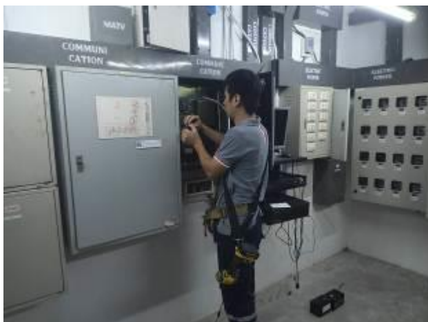
ผู้รับเหมาบริษัท มาสเตอร์ คอนโทรล เข้าดำเนินการเปลี่ยนตู้ Fire Alarm อาคาร C เนื่องจากของเดิมชำรุด
