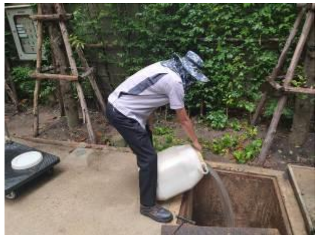
ช่างอาคารฯ เติมน้ำจูลินทรีย์ บริเวณบ่อบำบัดน้ำเสีย อาคาร A B และ C
