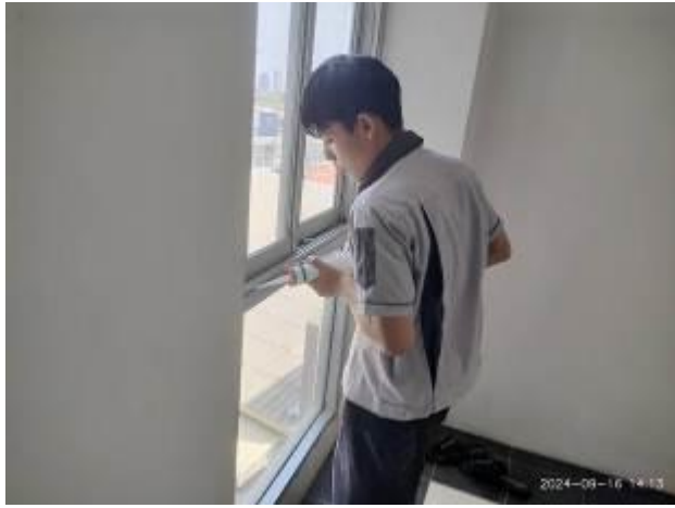
ช่างอาคารฯ ดำเนินการยิงซิลิโคนขอบเฟรม บริเวณชั้น 7 อาคาร C
