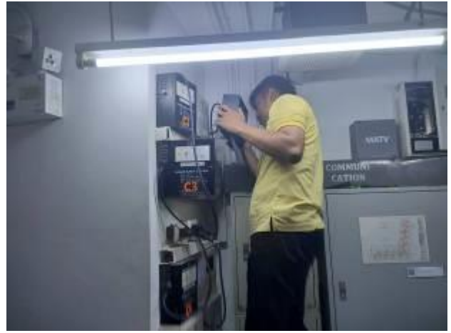
ช่างอาคารดำเนินการเปลี่ยน Power Supply บริเวณประตูเข้า-ออก ชั้น 1 อาคาร C
