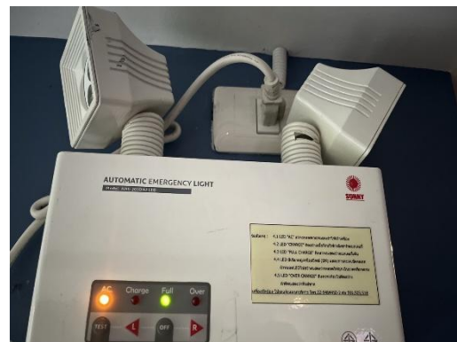
รูปที่ 42 ไฟส่องสว่างฉุกเฉิน
