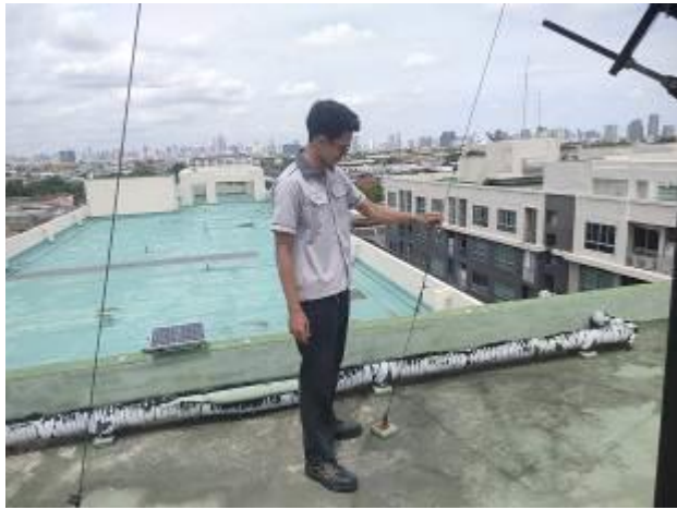
ช่างอาคารฯ ดำเนินการตรวจสอบเสาอากาศ MATV อาคาร A B และอาคาร C (ตามแผนงาน)
