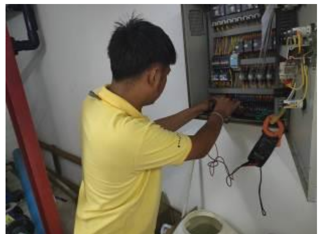
ช่างอาคารฯ ตรวจสอบระบบ Transfer pump อาคาร A B และ C (ตามแผนงาน)
