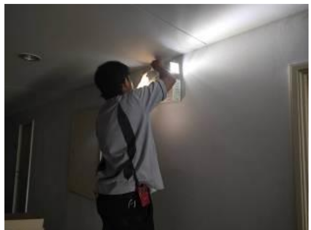
ช่างอาคารฯ ดำเนินการเปลี่ยนไฟฉุกเฉินที่ชำรุด บริเวณพื้นที่ส่วนกลางอาคาร A B และ C
