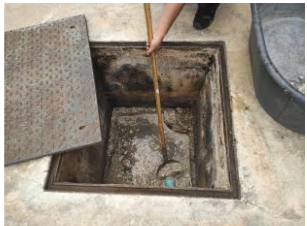
ช่างอาคารฯ ดำเนินการตักไขมัน บริเวณบ่อบำบัดน้ำเสีย อาคาร C
