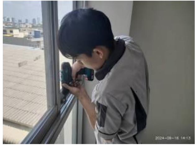
ช่างอาคารฯ ดำเนินการยิงซิลิโคนขอบเฟรม บริเวณชั้น 7 อาคาร C
