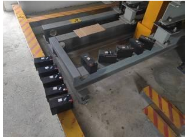
ช่างลิฟต์ดำเนินการเปลี่ยนแบตเตอรี่ ARD ระบบลิฟต์
