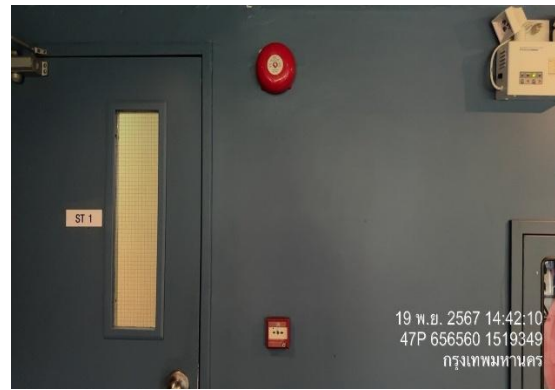
รูปที่ 32 อุปกรณ์แจ้งเหตุเพลิงไหม้แบบใช้มือ
