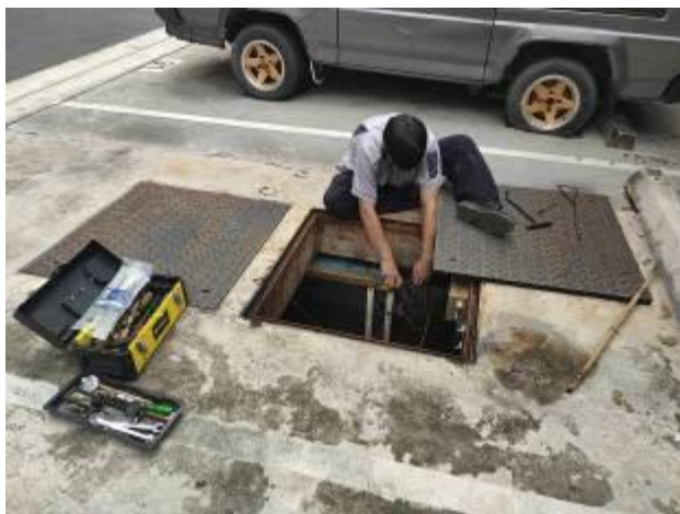
ช่างอาคารฯ ดำเนินการแก้ไขลูกลอยไม่ทำงาน บริเวณบ่อน้ำบาด อาคาร B
