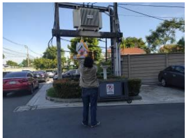
เจ้าหน้าที่การไฟฟ้าเข้าเทอร์โมสแกนหม้อแปลงและตู้ MDB อาคาร A B และอาคาร C
