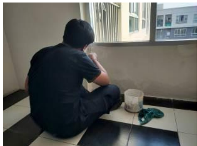
ช่างอาคารฯ ดำเนินการแก้ไขสีหลุดร่อน เนื่องจากน้ำรั่วซึม บริเวณหน้าต่างหน้าลิฟต์ชั้น 8 อาคาร B
