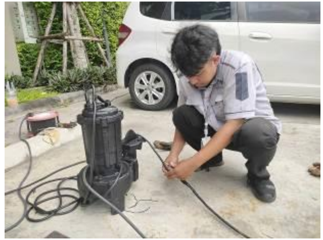
ช่างอาคารฯ ดำเนินติดตั้งปั๊มเติมอากาศ อาคาร A (ดำเนินการส่งซ่อมเนื่องจากขดลวดไหม้)
