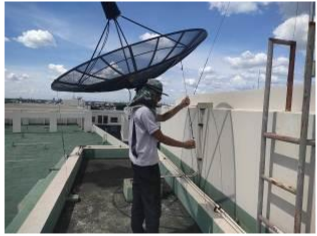
ช่างอาคารฯ ดำเนินการตรวจสอบเสาอากาศ MATV อาคาร A B และ C (ตามแผนงาน)
