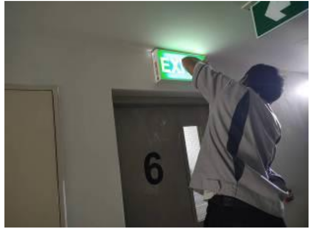
ช่างอาคารฯ ดำเนินการเปลี่ยนป้ายไฟทางออกฉุกเฉินที่ชำรุด (Exit Light) อาคาร A B และอาคาร C
