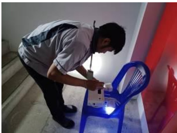
ช่างอาคารฯ ดำเนินการเปลี่ยนไฟฉุกเฉินที่ชำรุด บริเวณพื้นที่ส่วนกลางอาคาร A B และ C
