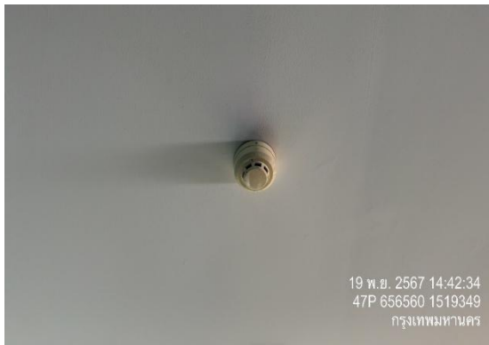
รูปที่ 35 อุปกรณ์ตรวจจับควันอัตโนมัติ
