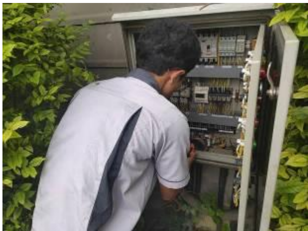
ช่างอาคารฯ ตรวจสอบระบบเตรนบีมบ่อน้ำทำยโครงการ (ตามแผนงาน)
