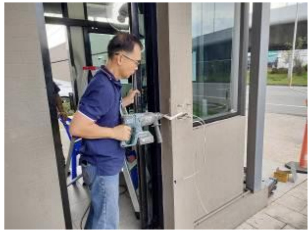
ผู้รับเหมาเข้าดำเนินการเดินสายสัญญาณระบบเข้า-ออก บริเวณไม้กระดกหน้าโครงการ เนื่องจากชำรุด
