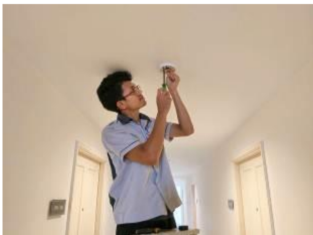
ช่างอาคารฯ ดำเนินการเปลี่ยนตัวตรวจจับควันไฟ (Smoke Detector) ที่ชำรุด
