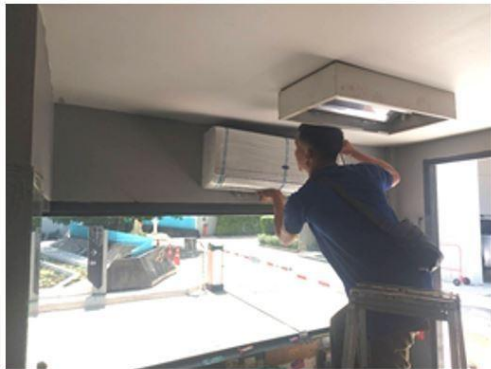
รูปที่ 27 ทำความสะอาดเครื่องปรับอากาศ
