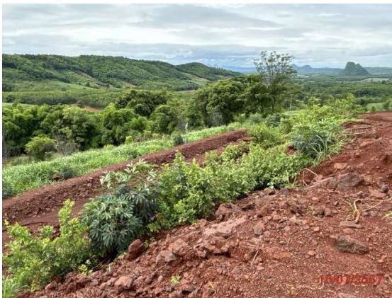
ภาพที่ 3.4.8-1 การปลูกพืชคลุมดิน และไม่ย่นต้นไม้บริเวณแนวคันทำนบดิน
