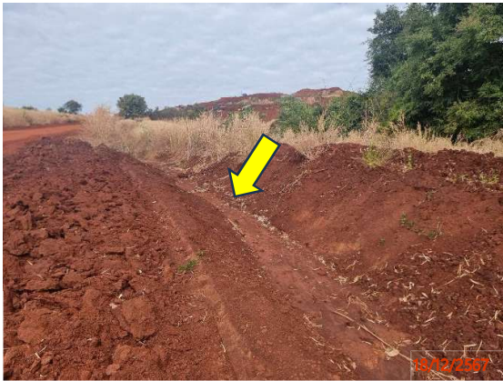
ภาพที่ 2-12 คูระบายน้ำรอบพื้นที่โครงการ
