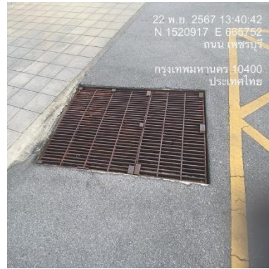
รูปที่ 22 การติดตั้งตะแกรงดักขยะไว้บริเวณ บ่อพักน้ำสุดท้ายก่อน
