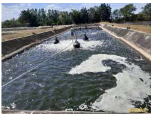
บ่อเติมอากาศ (Aerated Lagoon)
