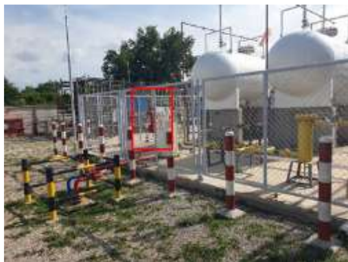
ภาพที่ 2.2-23 ตัวอย่างอุปกรณ์ป้องกันเหตุเพลิงไหม้สำหรับการเก็บก๊าซ LPG
