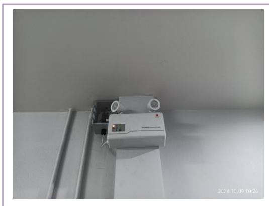
รูปที่ 2.13 ไฟแสงสว่างฉุกเฉิน
