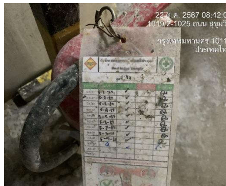
รูปที่ 30 การตรวจสอบอุปกรณ์ดับเพลิง
