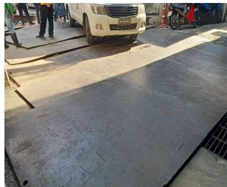
รูปที่ 15 แผ่นเหล็กปูพื้น
