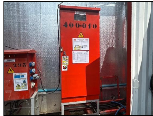
รูปที่ 80 แผงควบคุมไฟฟ้า และเครื่องตัดกระแสไฟฟ้าอัตโนมัติ
