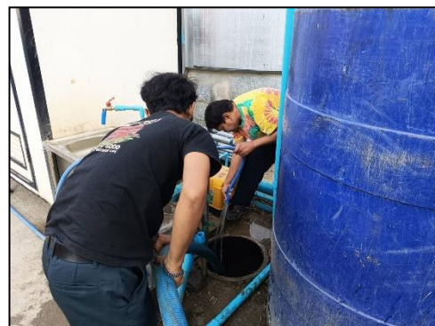
รูปที่ 45 ถังดักไขมัน และระบบบำบัดน้ำเสียแบบสำเร็จรูป ภายในพื้นที่ก่อสร้าง
