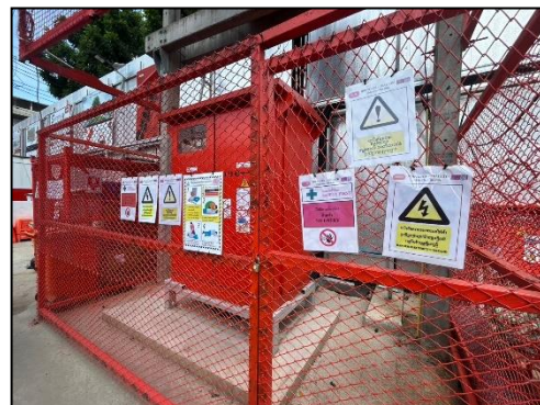
รูปที่ 66 มิเตอร์ไฟฟ้า และหม้อแปลงไฟฟ้าภายในพื้นที่ก่อสร้างโครงการ
