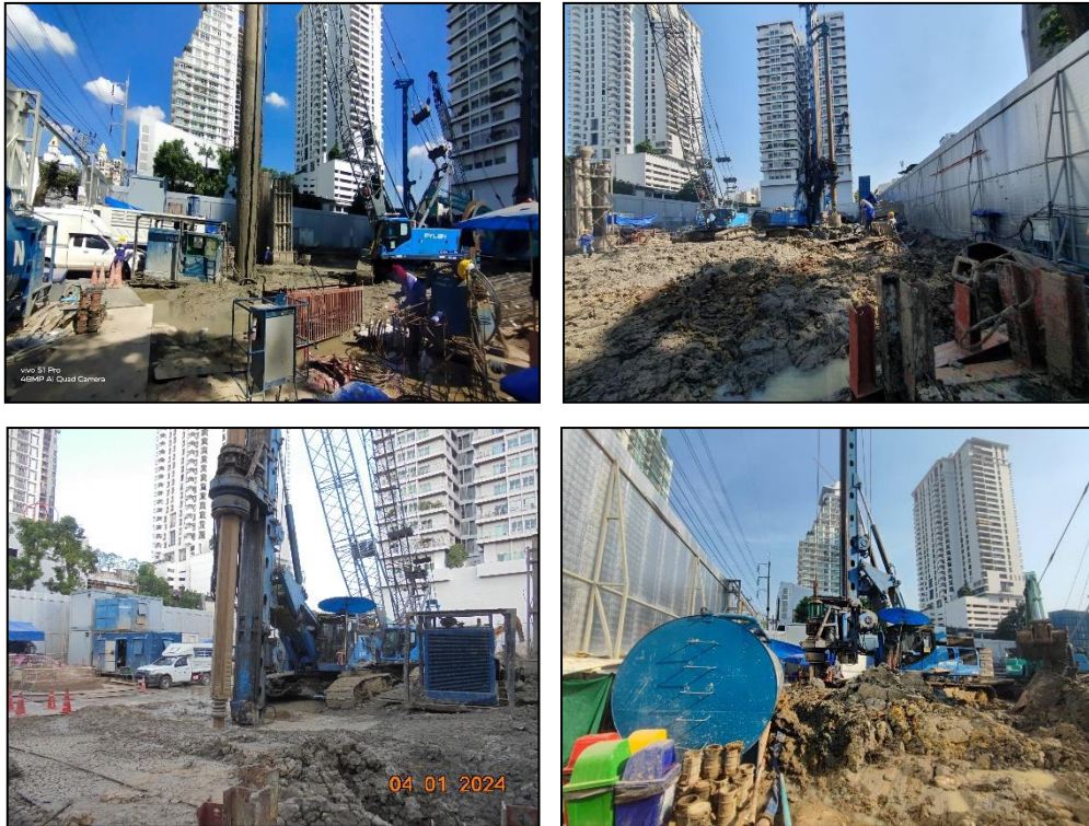
รูปที่ 31(ต่อ) เครื่องเจาะเสาเข็ม
