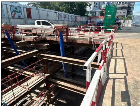
รูปที่ 88 ท่อลมดูดอากาศภายในพื้นที่โครงการ
