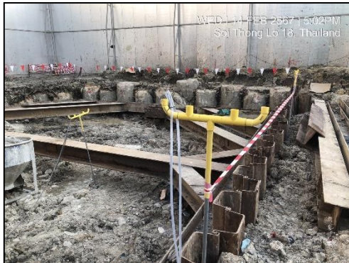
รูปที่ 10 ผนังกันดิน (pile wall)
