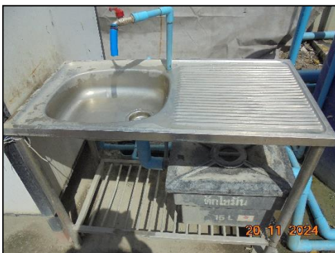
รูปที่ 45 ถังดักไขมัน และระบบบำบัดน้ำเสียแบบสำเร็จรูป ภายในพื้นที่ก่อสร้าง
