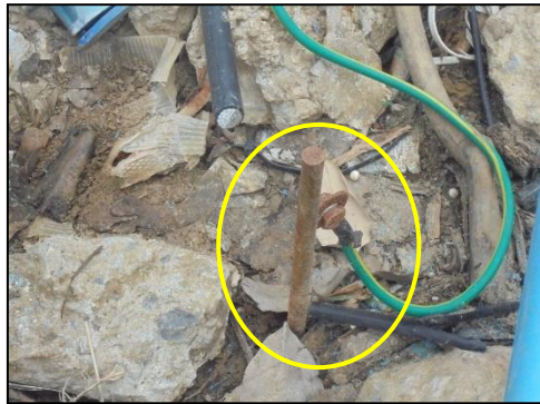
รูปที่ 111 จุดลงสายติดภายในพื้นที่โครงการ
