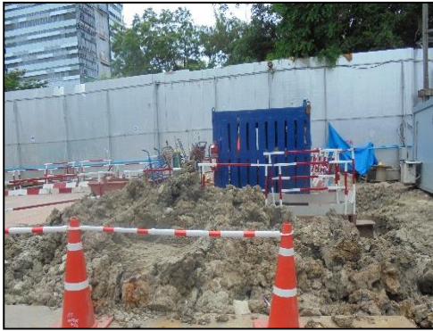
รูปที่ 40 รั้วกั้นกองดินภายในพื้นที่โครงการ
