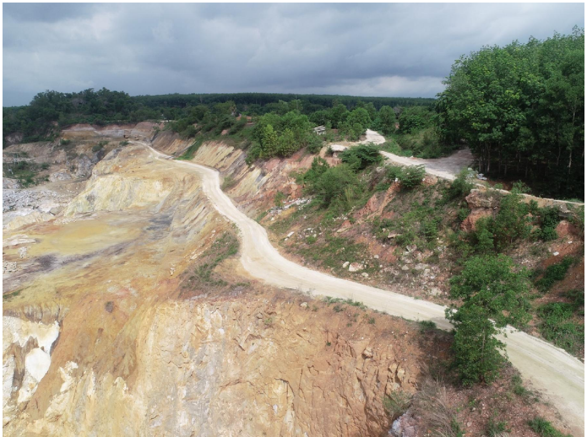
ภาพที่ 4 จุดถมดินทำชั้นบันไดป้องกันการพังทลายขอบบ่อด้านทิศตะวันตก
