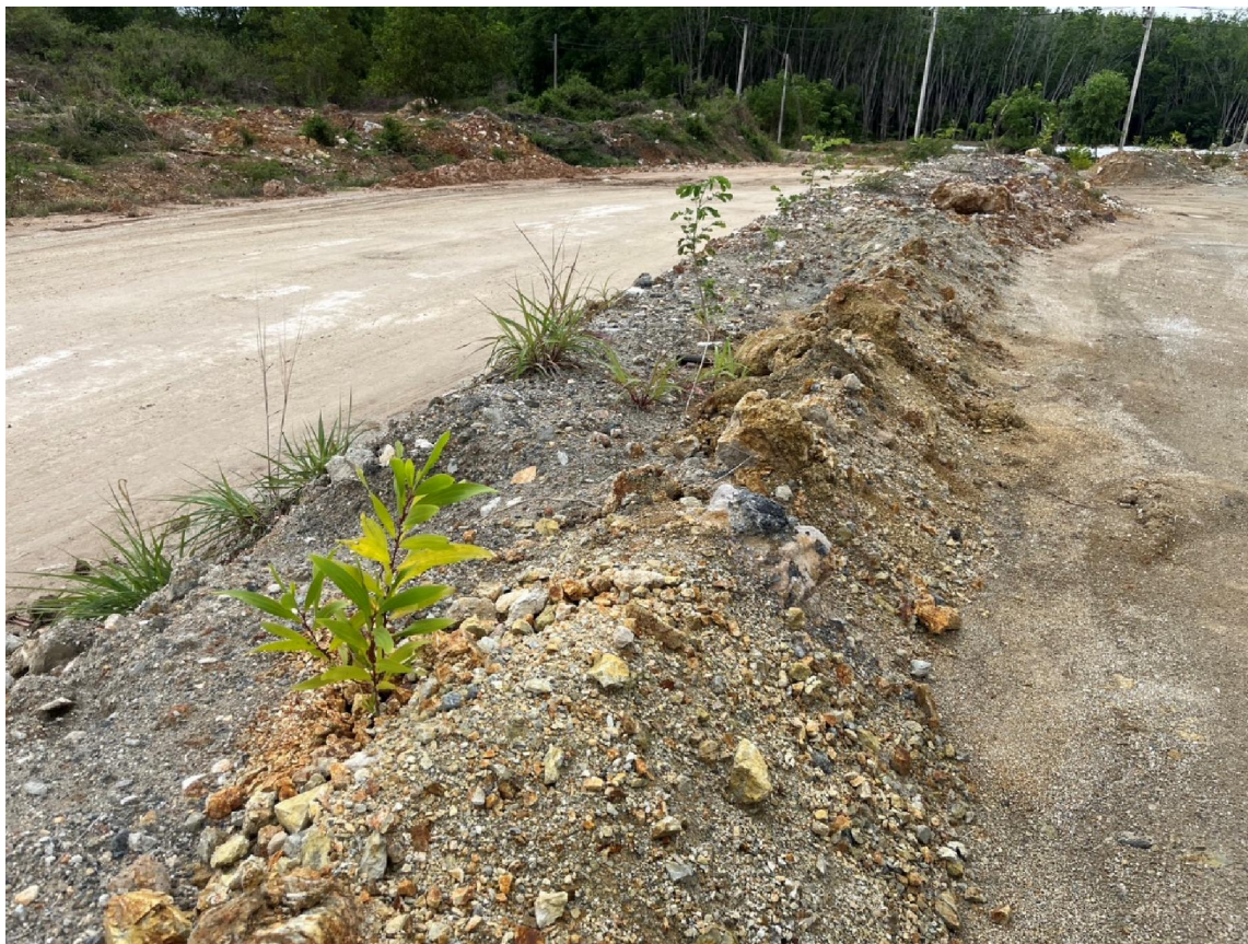
ภาพที่ 6 คั่นดินรอบเส้นทางขนส่งในพื้นที่โครงการ พร้อมปลูกต้นไม้ตลอดแนว
