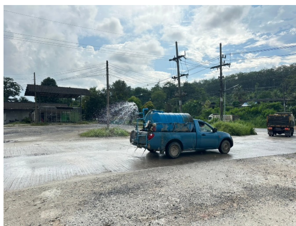
ภาพที่ 2-12 การฉีดพรมน้ำเพื่อป้องกันการฟุ้งกระจายของฝุ่น
