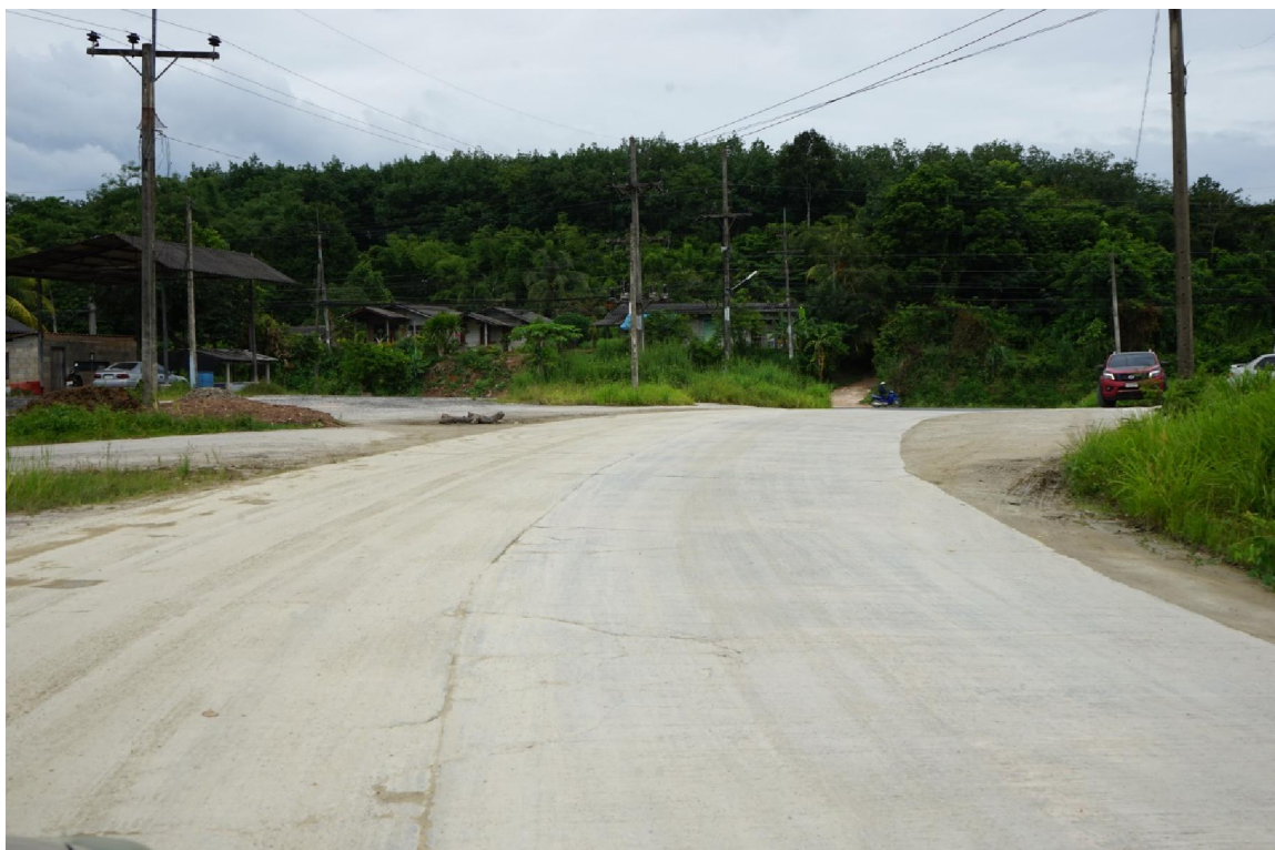
ภาพที่ 2 เส้นทางก่อนออกพื้นที่โครงการมีการเทคอนกรีต เพื่อลดปัญหาฝุ่นที่จะติดล้อสู่ถนนสายหลัก
