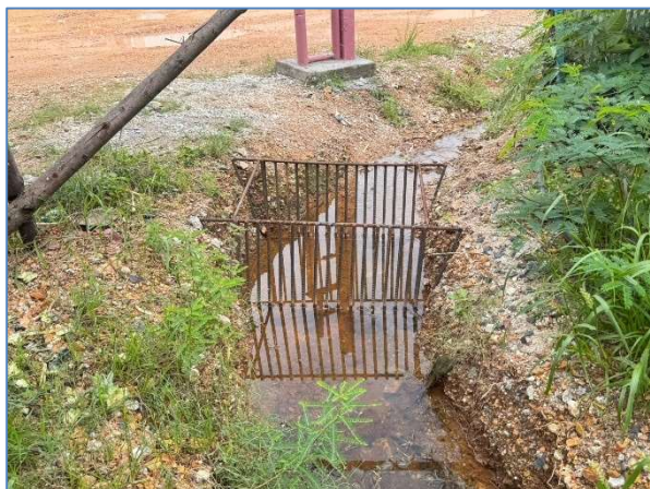
รูปที่ 2.2.2-24 ตะแกรงดักขยะ
