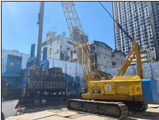
รูปที่ 38 การทำฐานรากแบบเสาเข็มกด
