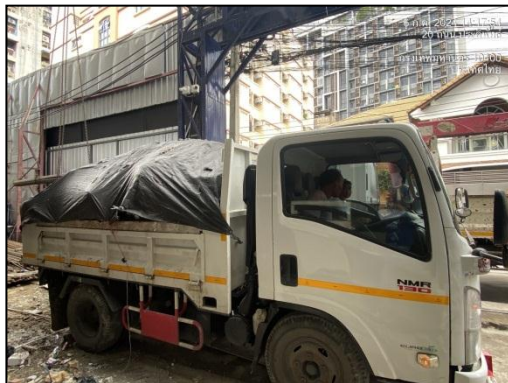
รูปที่ 26 รถบรรทุกขนส่งวัสดุก่อสร้าง ปิดคลุมผ้าใบมิดชิด
