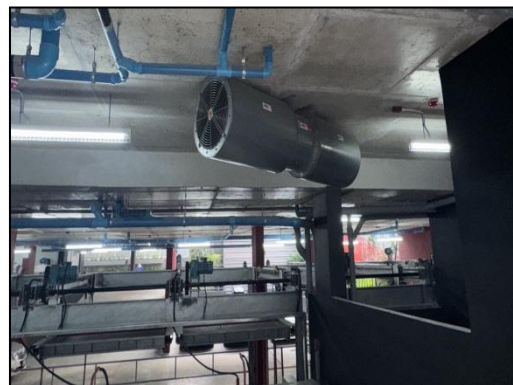
รูปที่ 35 พัดลมดูดอากาศบริเวณพื้นที่จอดรถของโครงการ
