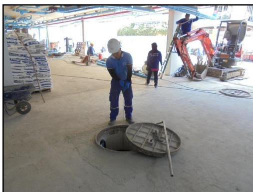
รูปที่ 3.4-1 บริเวณบ่อพักน้ำสุดท้ายของระบบระบายน้ำของโครงการก่อนระบายลงสู่ท่อสาธารณะ
