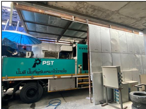
ผนังกันเสียงกันบริเวณท้ายรถป้อนคอนกรีตและรถปูน
