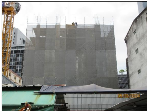
รูปที่ 18 ผ้าใบกันฝุ่นรอบอาคาร โครงการ
