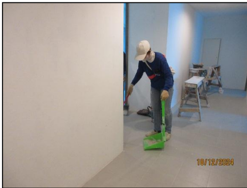
รูปที่ 14 คนงานคอยฉีดพรม และกวาดเศษดิน ทราช ที่ตกหล่นบริเวณพื้นที่ก่อสร้างโครงการ
