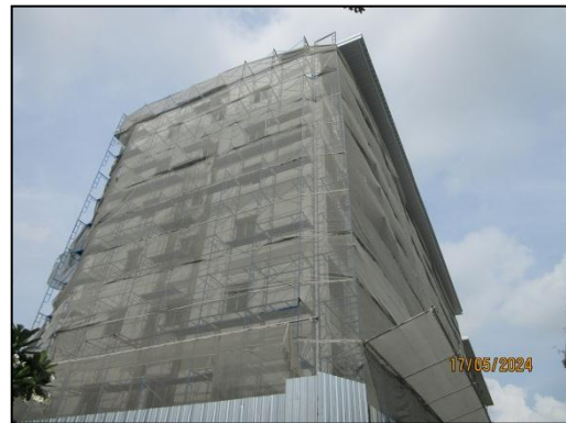
รูปที่ 11 ผ้าใบกันฝุ่นโดยรอบอาคาร โครงการ
