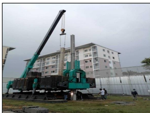
รูปที่ 6 การทำเสาเข็ม
