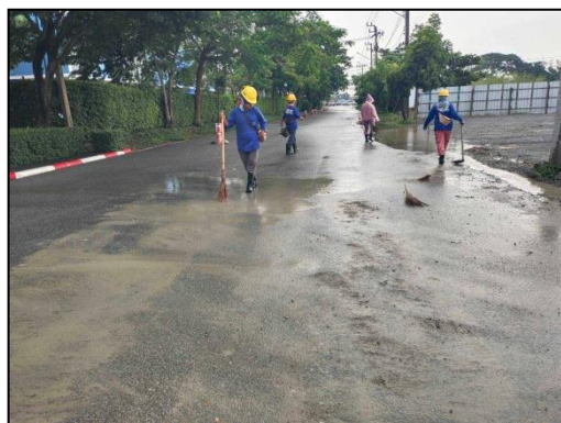
รูปที่ 7 คนงานฉีดพรมน้ำ และกวาดเศษดินบริเวณพื้นที่ก่อสร้าง และเส้นทางที่ใช้ในการขนส่งดินและวัสดุอุปกรณ์ก่อสร้าง
