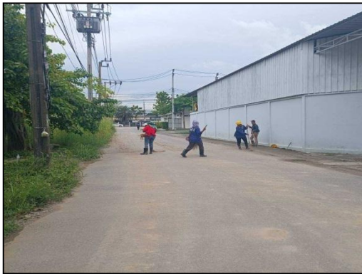
รูปที่ 7 (ต่อ) คนงานฉีดพรมน้ำ และกวาดเศษดินบริเวณพื้นที่ก่อสร้าง และเส้นทางที่ใช้ในการขนส่งดินและวัสดุอุปกรณ์ก่อสร้าง
