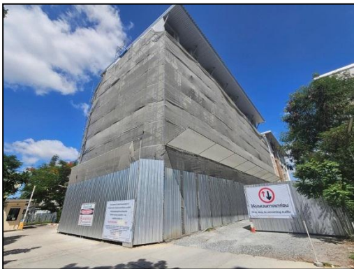
รูปที่ 11 ผ้าใบกันฝุ่นโดยรอบอาคาร โครงการ
