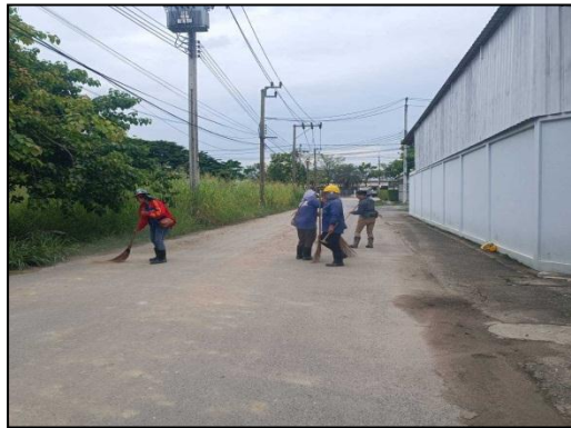
รูปที่ 7 (ต่อ) คนงานฉีดพรมน้ำ และกวาดเศษดินบริเวณพื้นที่ก่อสร้าง และเส้นทางที่ใช้ในการขนส่งดินและวัสดุอุปกรณ์ก่อสร้าง
