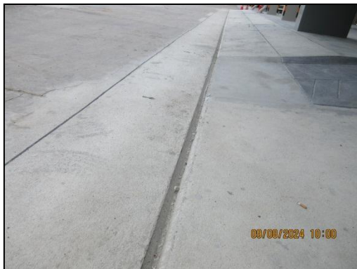
รูปที่ 21 รางระบายน้ำ/ท่อระบายน้ำบริเวณโครงการ
