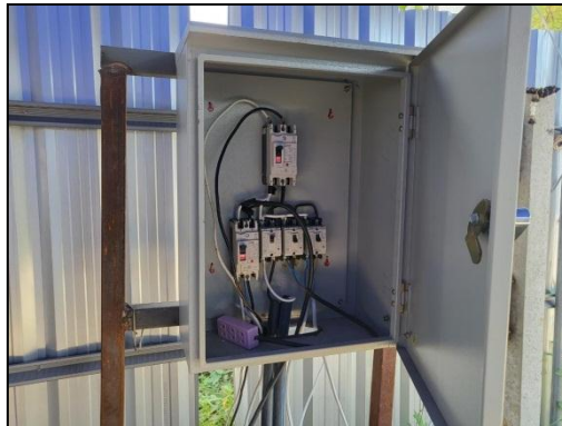
รูปที่ 50 อุปกรณ์ตัดไฟของโครงการ
